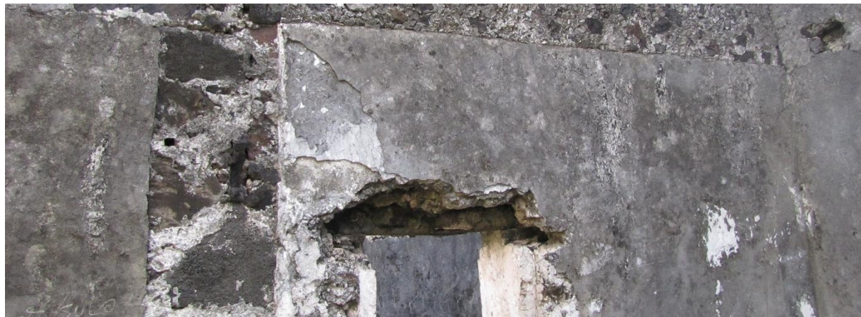
Figure 156 : Porte Ic003, détail du linteau
