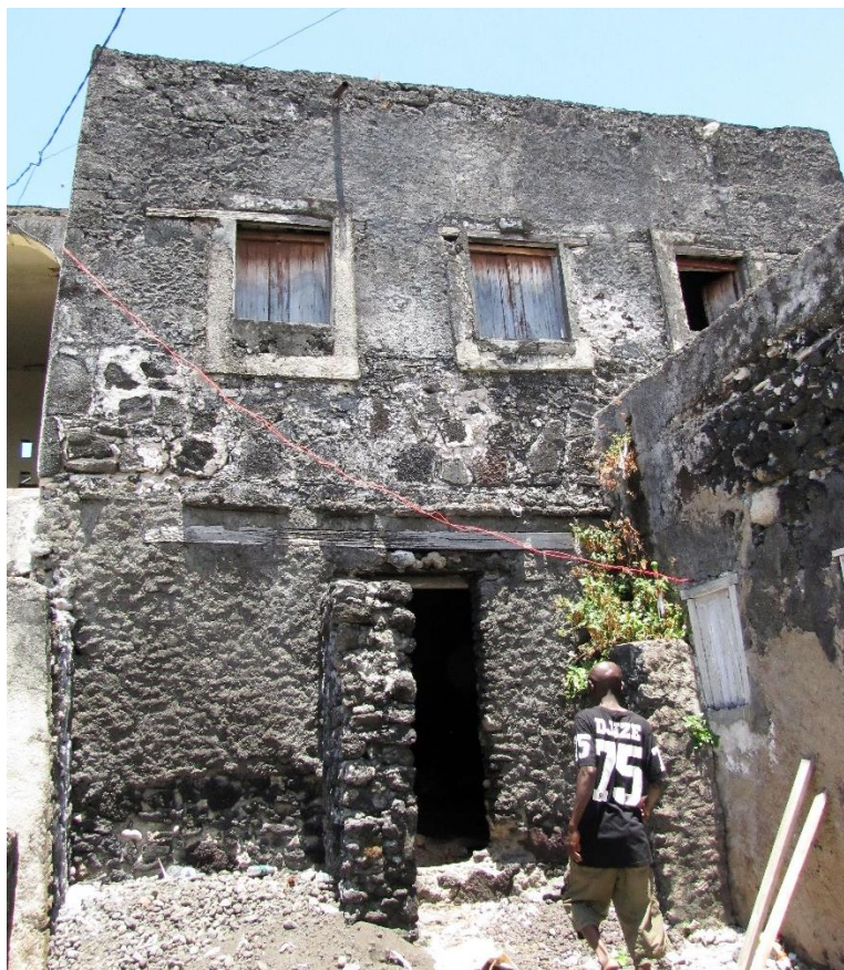
Figure 20 : Palais du sultan Saïd Hussein, Fumbuni, Grande Comore
