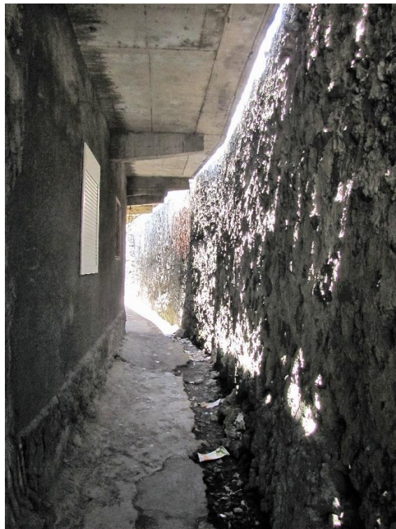
Figure 38 : Mur desservant les portes et tours, Itsandra, Grande Comore
