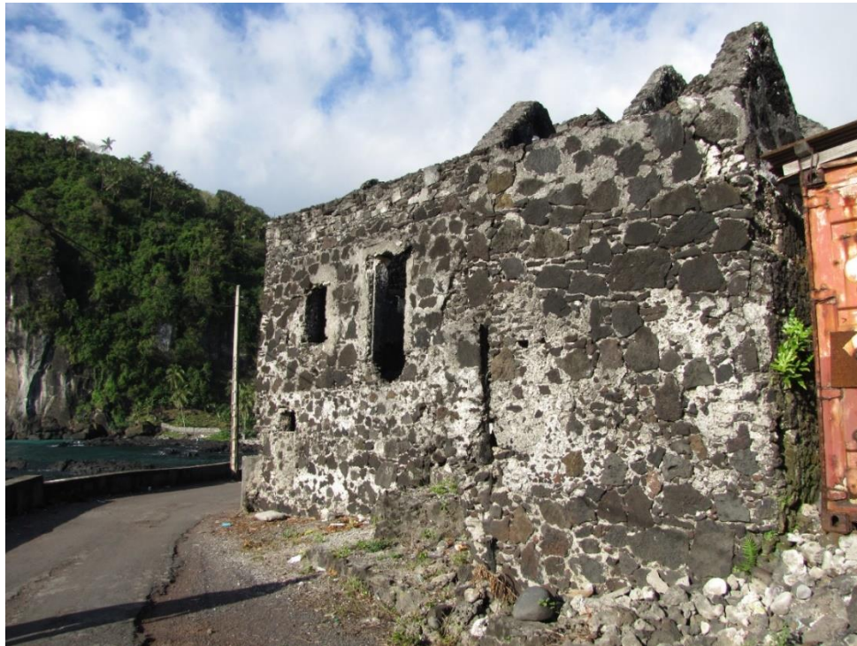
Figure 148 : Palais Kavhiridjewe, mur gouttereau ouest de la grande salle, vue extérieure.
