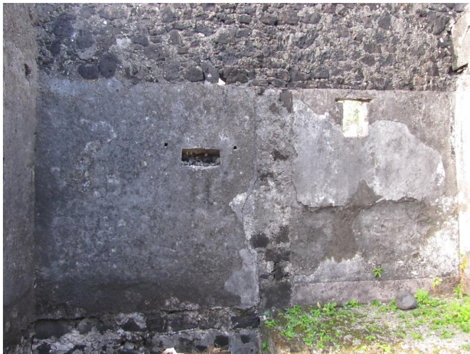
Figure 152 : Grande salle, mur pignon nord avec niche murale
