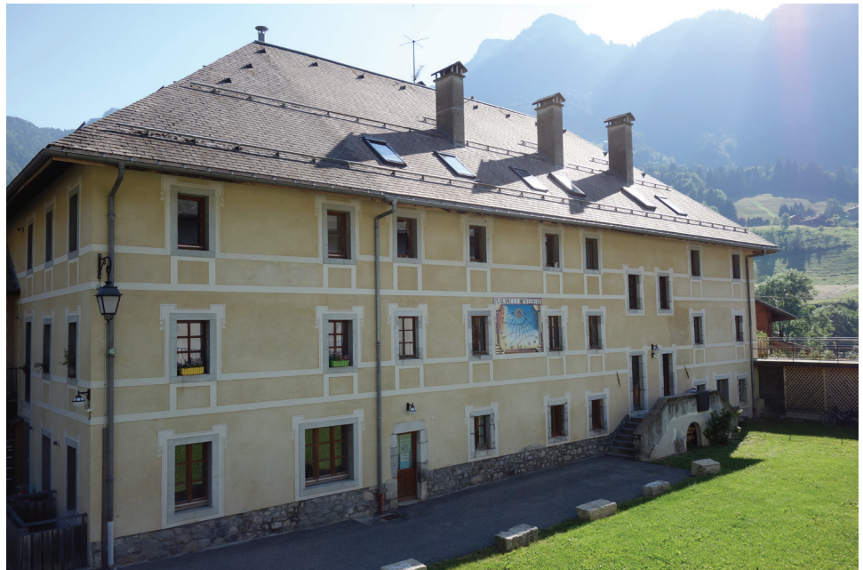
Fig. 10 - La façade sud de l'aile nord.
