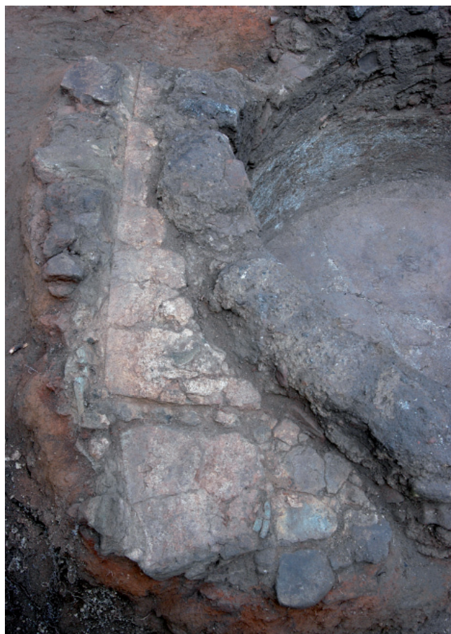
Fig. 3b – Détail du laboratoire du four en partie détruit par l'installation de la cuve 16
