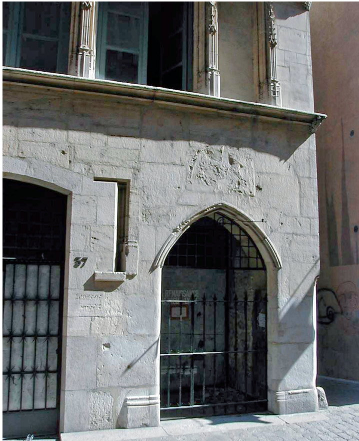
Fig. 1. Porte ogivale de la maison du Chamarié, rue Saint-Jean-Baptiste, Lyon, dont les bases des piédroits sont majoritairement en choin. Cliché : Gh. Macabéo, Inrap-UMR 5138.
