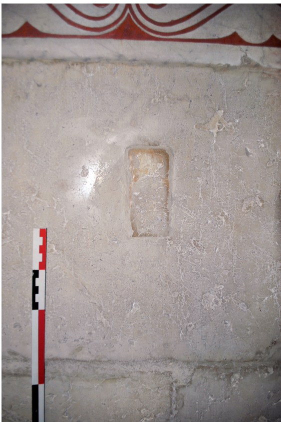
▲ Fig. 10. Dalles de choin formant le sol de l'abside de l'oratoire du vi s. dans l'église abbatiale Saint-André-le-Haut de Vienne (Isère). Cliché : A. Baud et A. Flammin, Université Lyon 2-CNRS-UMR 5138.
