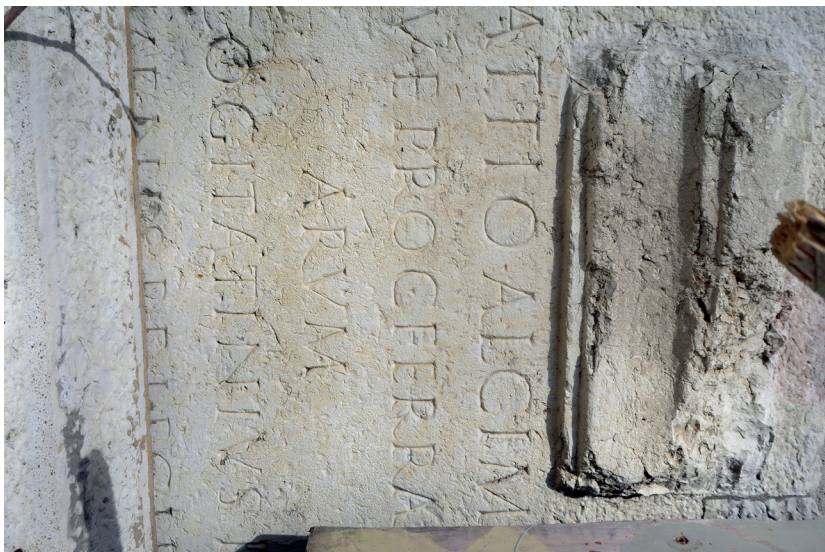
Fig. 28. Bloc antique épigraphique retourné et dont la moulure supérieure a été taillée en bossage; chevet, travée sud de la cathédrale Saint-Jean-Baptiste (Lyon). Cliché: N. Reveyron, Université Lyon 2-UMR 5138.
