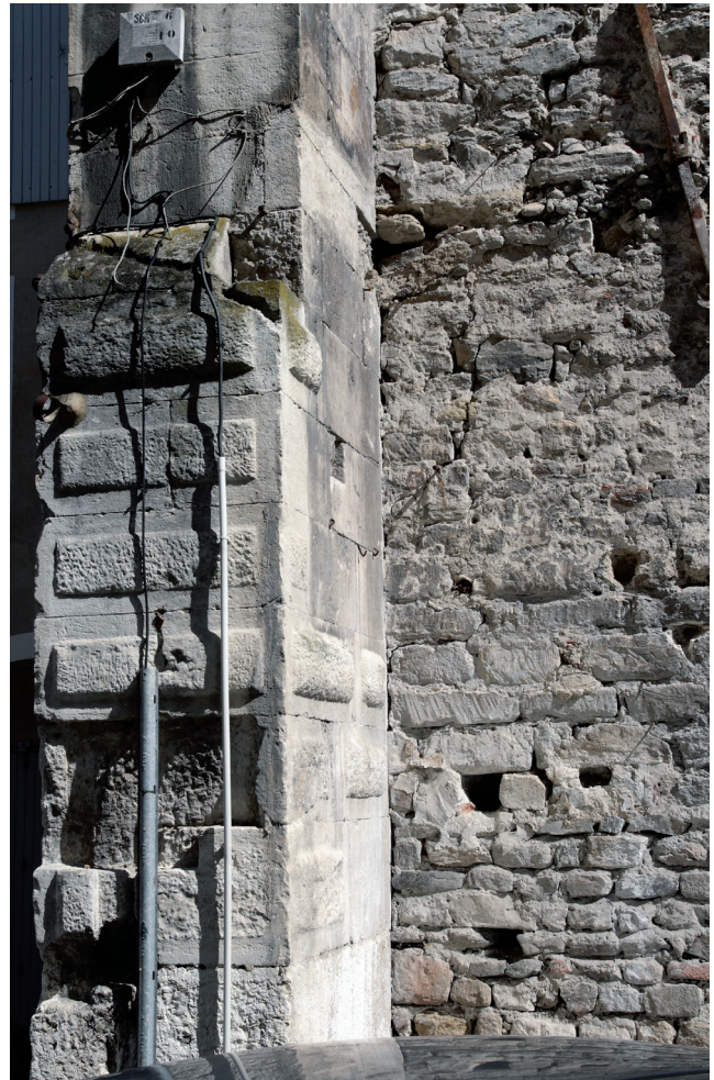
Fig. 19. Contrefort extérieur du mur gouttereau sud de l'église abbatiale Saint-André-le-Haut de Vienne (Isère). Cliché : A. Baud et A. Flammin, Université Lyon 2-UMR 5138.
