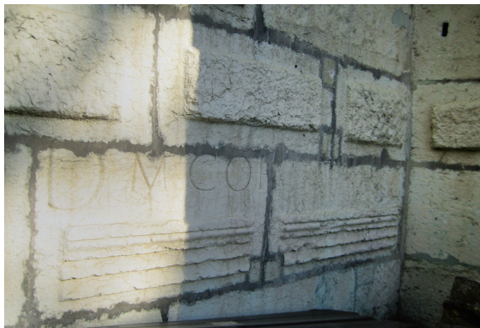
◄ Fig. 16. Cathédrale Saint-Jean-Baptiste (Lyon), chevet : vue des assises de choïn, longs blocs antiques en remploi. Cliché : Gh. Macabéo, Inrap-UMR 5138.
