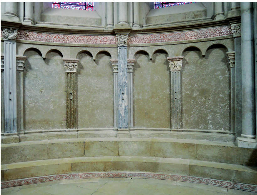
Fig. 29. Abside, banc presbytéral: vue générale du décor d'arcatures et d'orthostates après restauration (2013-2014). Cathédrale Saint-Jean-Baptiste (Lyon). Cliché: E. Boissard, DRAC-SRA-UMR 5138.
