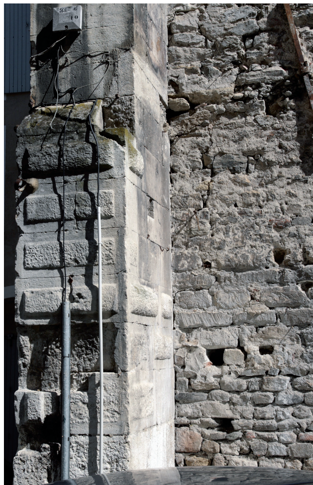
Fig. 19. Contrefort extérieur du mur gouttereau sud de l'église abbatiale Saint-André-le-Haut de Vienne (Isère). Cliché : A. Baud et A. Flammin, Université Lyon 2-UMR 5138.
