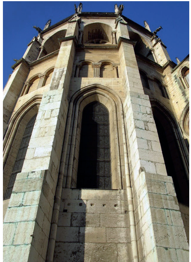
Fig. 20. Contreforts et murs du premier niveau de l'abside en choin de Fay du chevet de la cathédrale Saint-Jean-Baptiste (Lyon). Cliché : Gh. Macabéo, Inrap-UMR 5138.
