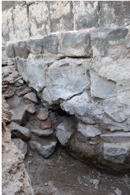
Fig.11 :Vue des gros blocs qui composent la fondation du mur en C5 au N de la plateforme (BC)
