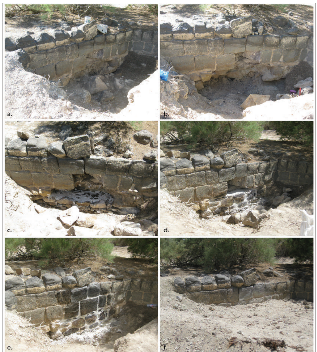
Fig.37 :Les étapes du chantier de restauration dans le secteur 5 a) avant les travaux b) après la purge et le nettoyage c) base des fondations en place d) assises de fondations en place e) assise taillée restaurée f) après le rebouchage (LAA)
