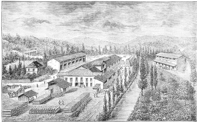
USINE DE VIF
