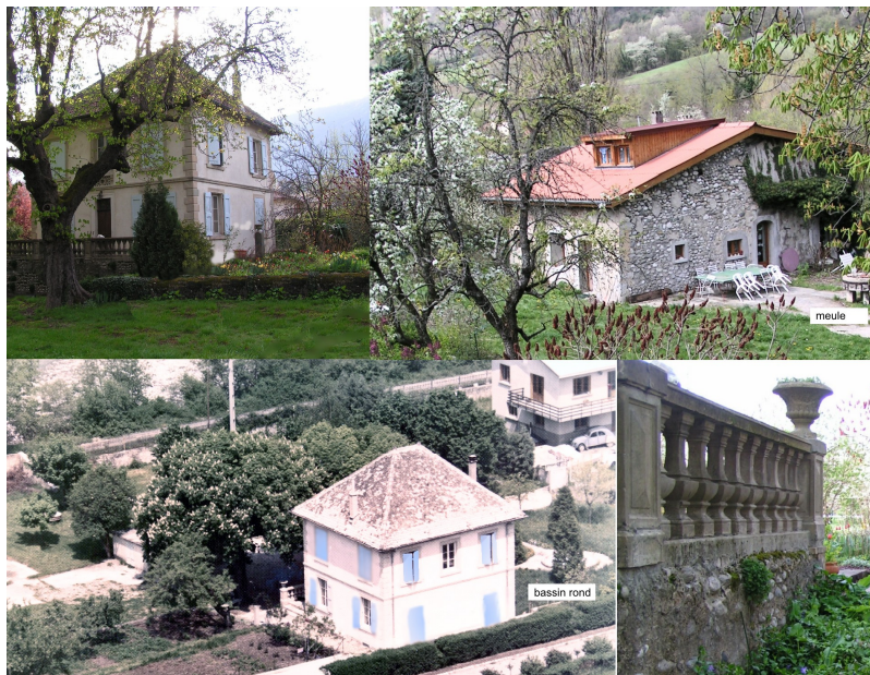
Figure 4. Site de l'usine de La Grange à Vif. Gauche, La maison du directeur (à l'origine Louis-Joseph Pétrequin) avec ses pierres d'angle en ciment ; la balustrade et le vase en ciment sont représentatifs des produits vendus par l'usine, état actuel. Un bâtiment industriel est conservé, construit en galets de la Gresse (droite). Devant ce bâtiment, une des quatre meules de pierre conservées, a été dressée sur quatre piliers de ciment. Bas, à gauche, vue aérienne des années 1970.
