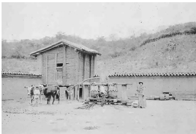
2. Indígenas chiriguano trabajando en el procesamiento de la caña de azúcar con un trapiche en la Misión de la Purísima de Tarairí (Bolivia) a fines del siglo XIX. Fuente: GIANNECCHINI, MASCIÓ 1898.
