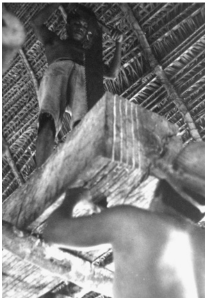
2. Aserrando las vigas de una casa en construcción en Casarabe. Fuente: ACLB, «Técnica del trabajo», sin fecha, p. 14.
