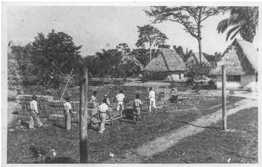
3. Trabajando en los cimientos de la capilla de Moré. Fuente: ALLC, Álbum de fotografías, lámina 7 rev.
