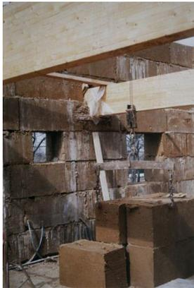
Photographies non-datées de chantiers avec des blocs de bauge préfabriqués par l'artisan-maçon spécialiste de procédé de construction. Ces photographies ont probablement été prises autour des années 1990, lorsque la plupart des maisons en blocs de bauge préfabriqués ont été édifiées.
