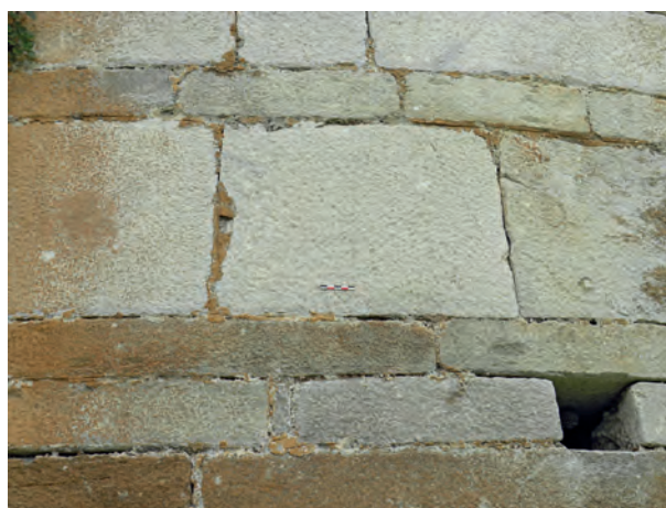
Fig. 4 – Détail du parement extérieur de l'abside. On remarque différentes techniques de taille (D. Istria/CNRS).
