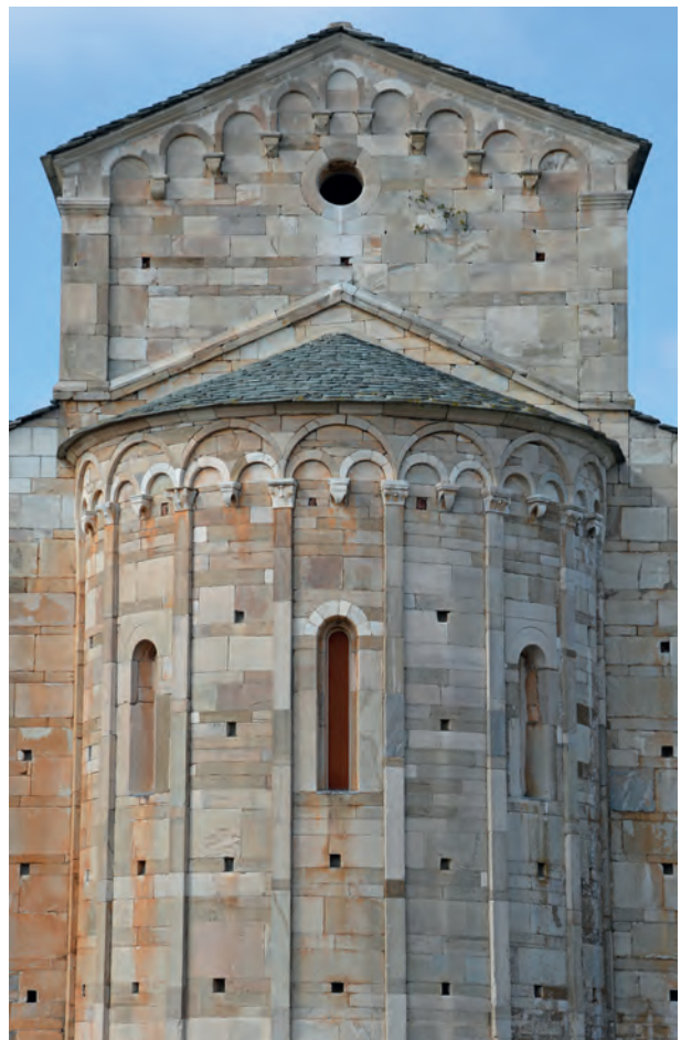
Fig. 18 – Façade orientale de la cathédrale. Les rythmes des assises entre les lésènes de l'abside sont irréguliers (D. Istria/CNRS).
