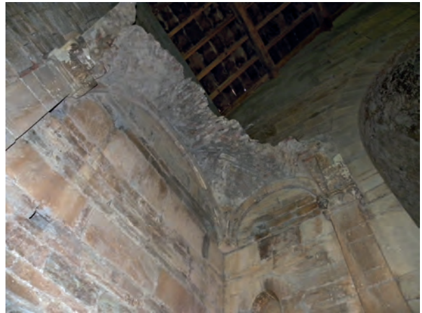
Fig. 6 – Détail de l'espace voûté nord (D. Istria/CNRS).
