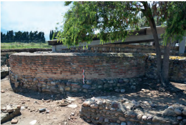
Fig. 11 – L'abside vue du nord-est. On remarquera la semelle de fondation débordante en galets ainsi que les restaurations récentes (post 1960) qui ont surélevé le mur de 4 à 5 assises de briques (partie haute et foncée) (D. Istria/CNRS).
