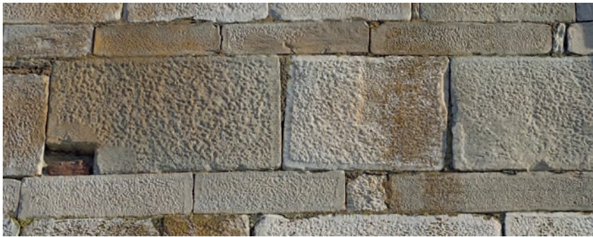
Fig. 27 – Détail du parement extérieur de la façade occidentale, étape 3. La taille de la surface des trois blocs de la partie centrale n'a pas été terminée. On peut voir sur le bloc du centre la progression du travail – 1/ dégrossissage à la broche, 2/ taille de la ciselure périmétrale, 3/ finition à la broche (P. Neri/CTC).
