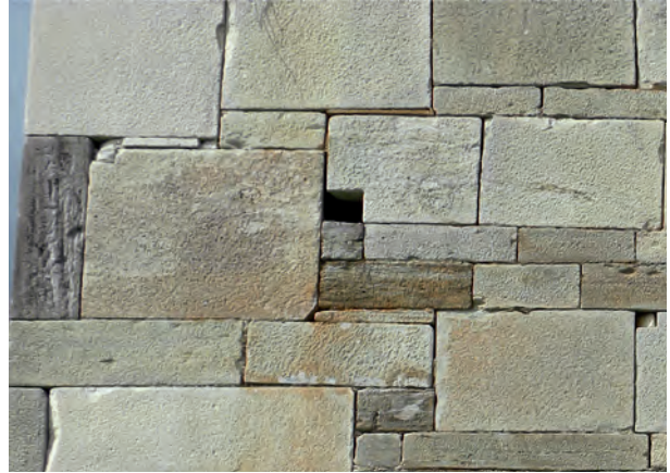
Fig. 9 – Détail du parement extérieur du mur gouttereau sud, extrémité occidentale du mur (D. Istria/CNRS).
