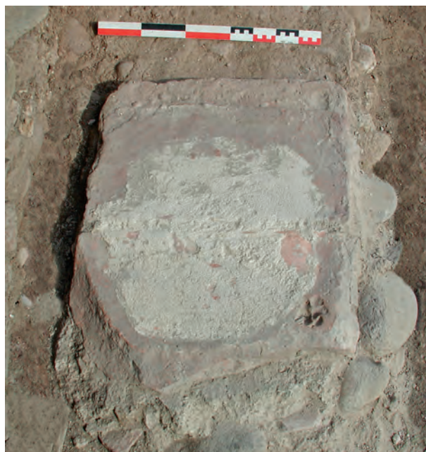
Fig. 14 – Sous-base de la colonne 308 après démontage du pilier en briques de l'état 2 et destruction du sol de béton de chaux (D. Istria/CNRS).
