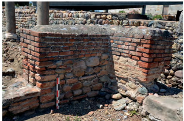
Fig. 12 – Épaule-ment sud-est de l'abside. Les jambages des deux portes ouvrant sur l'abside et le collatéral sud sont entièrement en briques comme la partie haute des élévations reposant sur un soubassement de galets. Le « chapeau » constitué de galets liés au ciment correspond à la restauration récente (post 1960) (D. Istria/CNRS).
