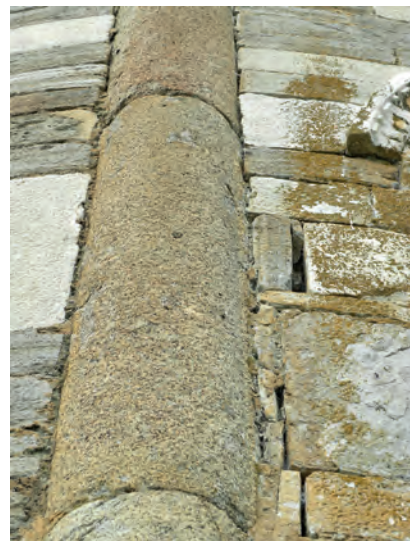
Fig. 32 – Détail de l'insertion de la colonne dans le mur de l'abside (D. Istria/CNRS).
