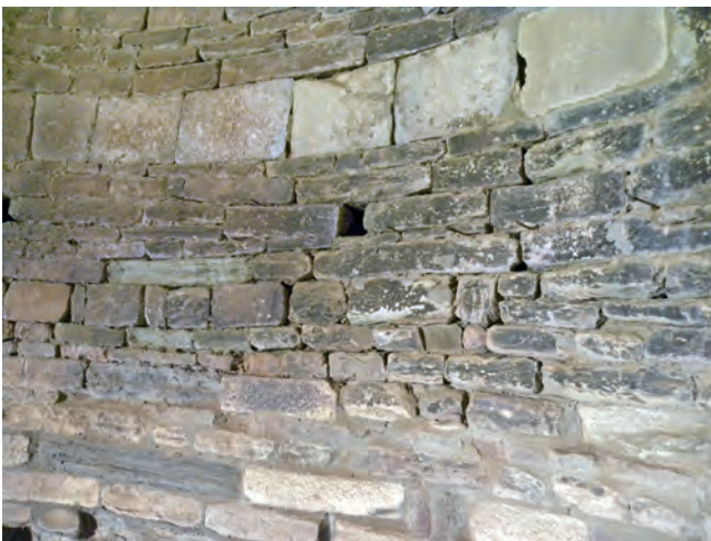
Fig. 7 – Parement intérieur du mur absidal. On note la présence d'une assise haute constituée de blocs taillés posés en délit (D. Istria/CNRS).
