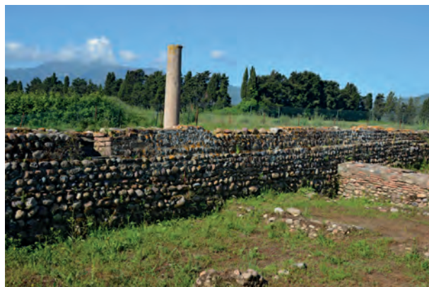
Fig. 8 – Fondation du palais épiscopal, mur sud de l'aile méridionale vu du nord-est (D. Istria/CNRS).
