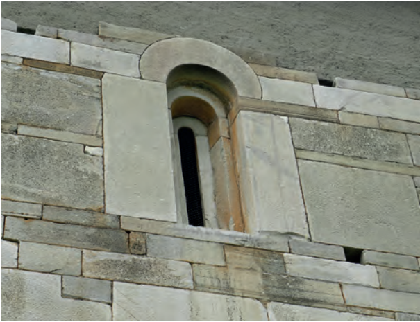
Fig. 18 – Fenêtre du mur gouttereau sud vue de l'extérieur (D. Istria).
