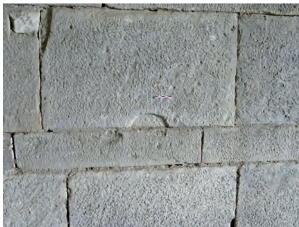
Fig. 3 – Trace semi-circulaire sur un bloc de parement intérieur du mur nord – possible emboîture (D. Istria/CNRS).
