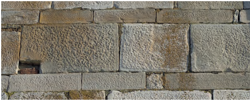
Fig. 27 – Détail du parement extérieur de la façade occidentale, étape 3. La taille de la surface des trois blocs de la partie centrale n'a pas été terminée. On peut voir sur le bloc du centre la progression du travail – 1/ dégrossissage à la broche, 2/ taille de la ciselure périmétrale, 3/ finition à la broche (P. Neri/CTC).
