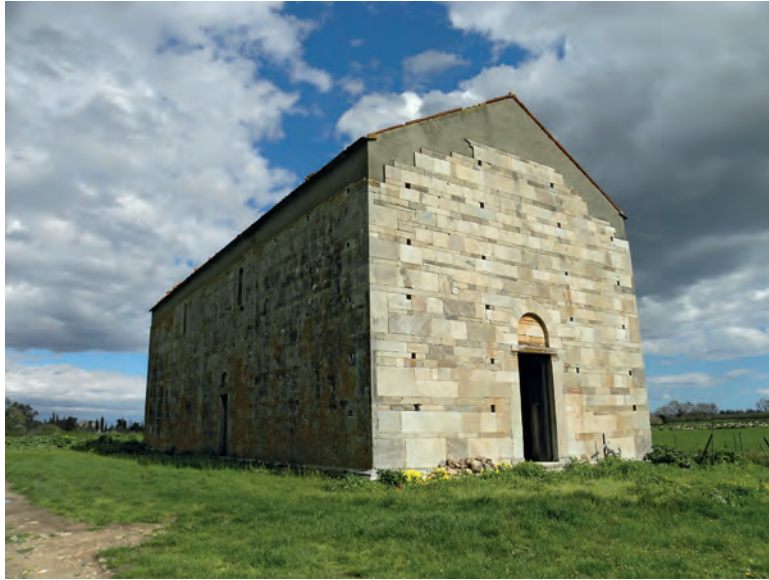
Fig. 1 – La façade occidentale vue depuis le nord-ouest (D. Istria/CNRS).
