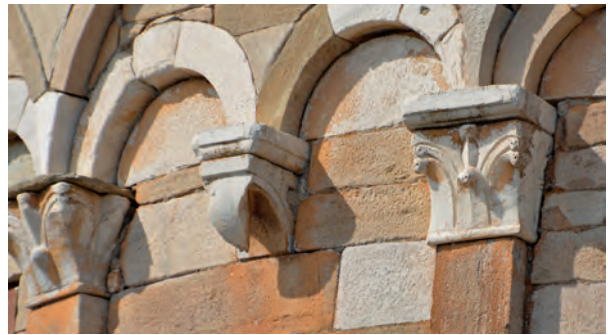
Fig. 22 – Détail du décor de l'abside montrant les « bricolages » qui ont été nécessaires pour insérer les chapiteaux et les modillons (D. Istria/CNRS).
