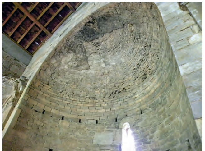
Fig. 8 – Paroi intérieure de l'abside encore partiellement couverte d'enduit (D. Istria/CNRS).
