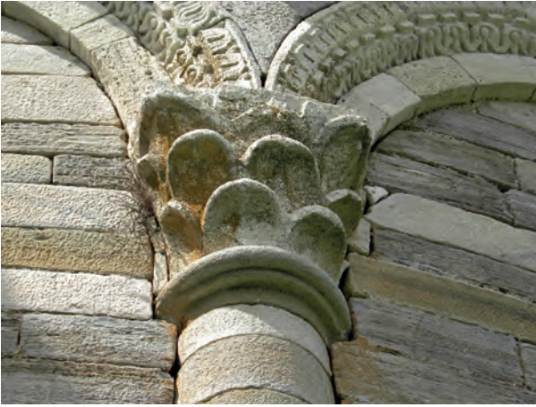
Fig. 22 – Premier chapiteau de l'abside en partant du sud (D. Istria/CNRS).
