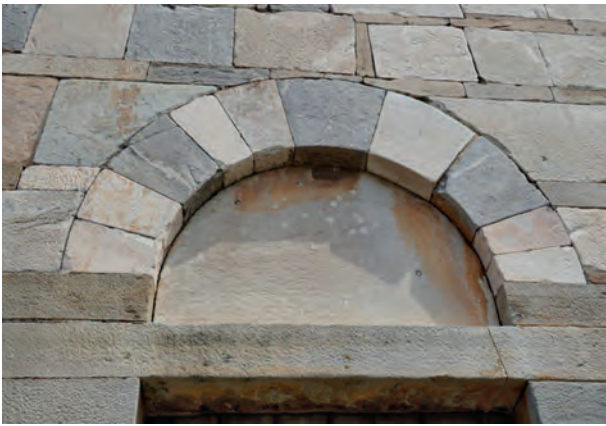
Fig. 19 – Détail de la partie haute de la porte sud-ouest (D. Istria/CNRS).
