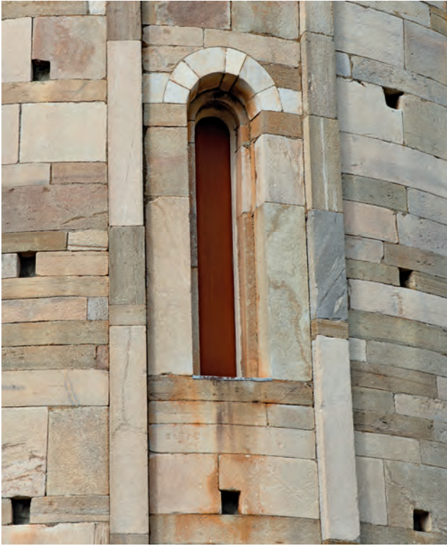
Fig. 33 – Fenêtre centrale de l'abside (D. Istria/CNRS).
