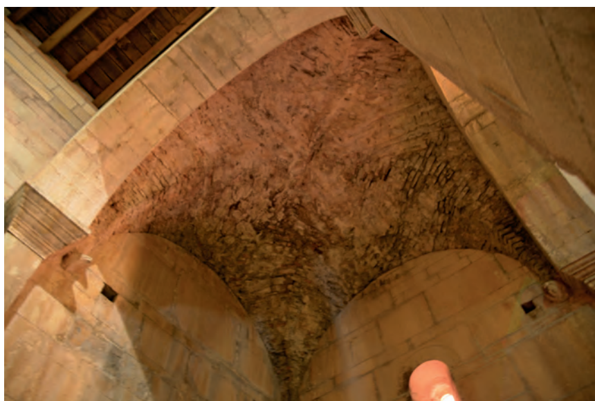
Fig. 37 – Voûte de la dernière travée orientale, collatéral nord (D. Istria/CNRS).
