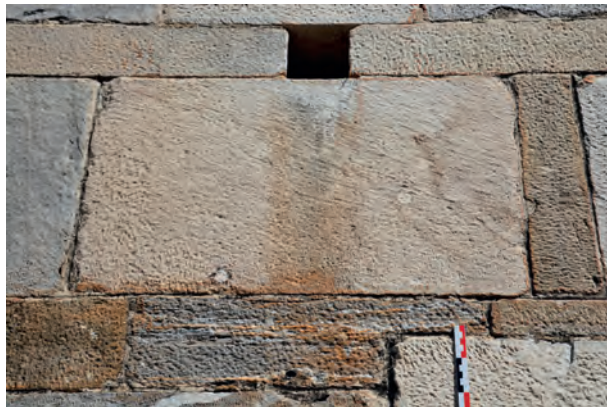
Fig. 15 – Bloc de la façade sud, parement extérieur, présentant les traces de trois outils différents utilisés dans l'ordre suivant – la brette (partie haute), la broche (partie basse) et le ciseau droit (bordure basse) (D. Istria/CNRS).
