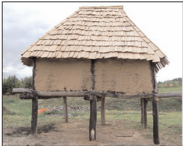
Fig. 16 : vue est du grenier achevé
