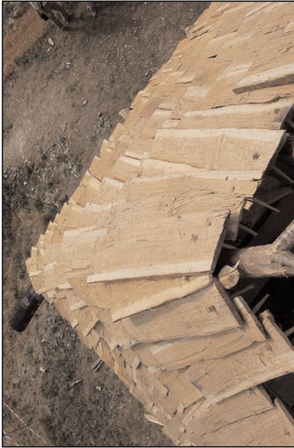
Fig. 11 : arêtier réalisé par recouvrement latéral des bardeaux
