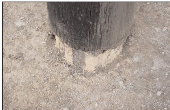
Fig. 23 : comblement par les terres de surface du vide laissé par la perte de l'aubier
