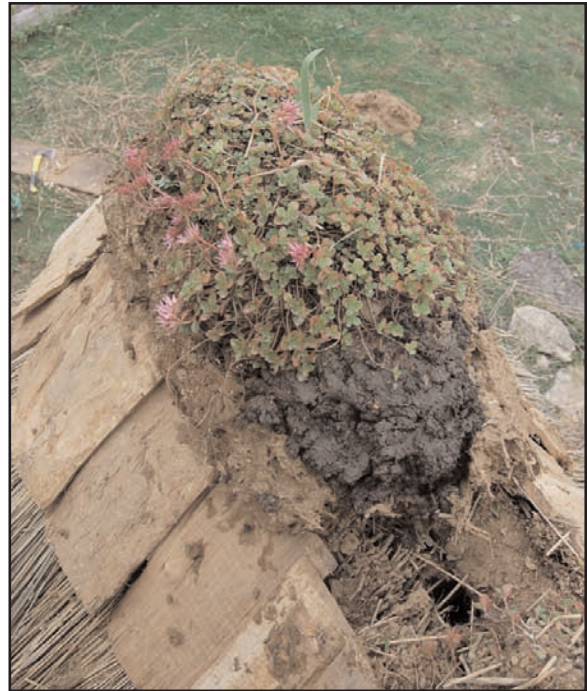
Fig. 27 : confection d'une gouttière en argile remplie de terres noires pour les plantations d'iris et de joubardes
