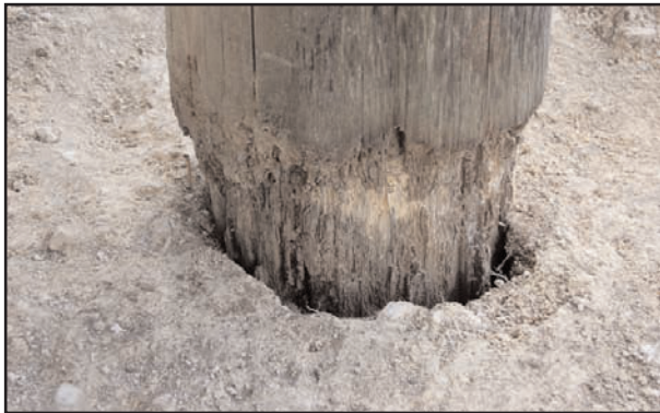
Fig. 21 : décomposition de l'aubier en périphérie du bois
