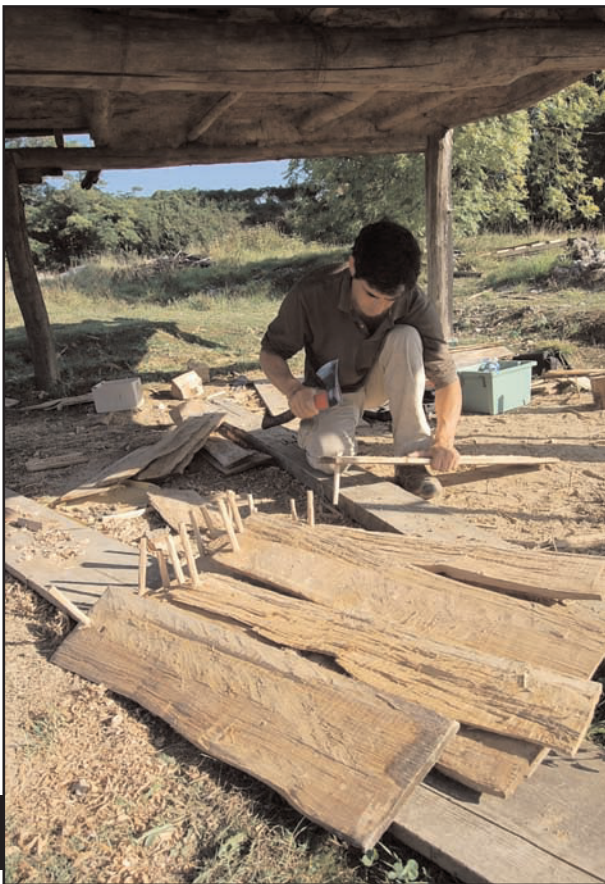
Fig. 9 : fixation des chevilles dans les bardeaux
