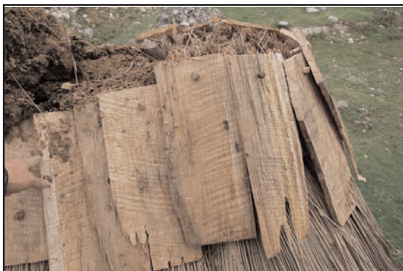
Fig. 26 : recouvrement des liens par des bardeaux
