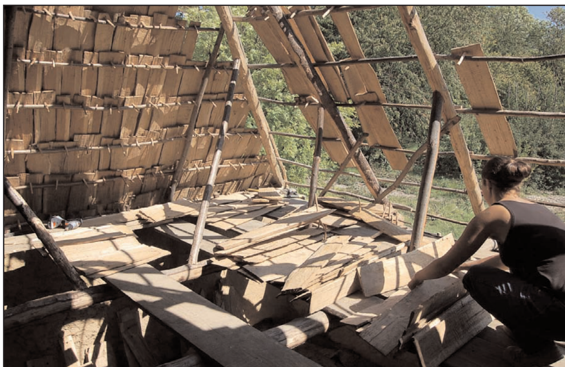
Fig. 10 : stockage des bardeaux sur le plancher provisoire au niveau des entrants
