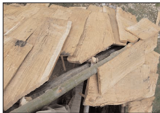
Fig. 13 : arêtier réalisé avec deux rangs parallèles de bardeaux longitudinaux
