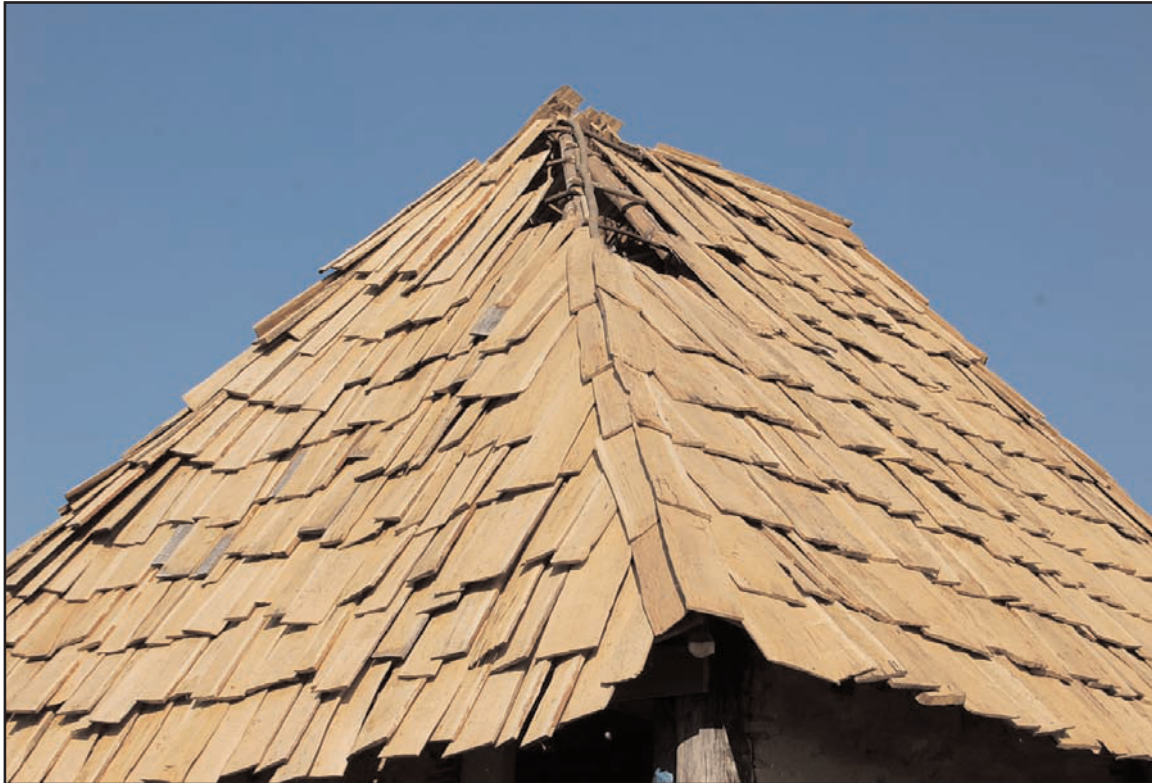
Fig. 14 : arêtier en cours de réalisation
