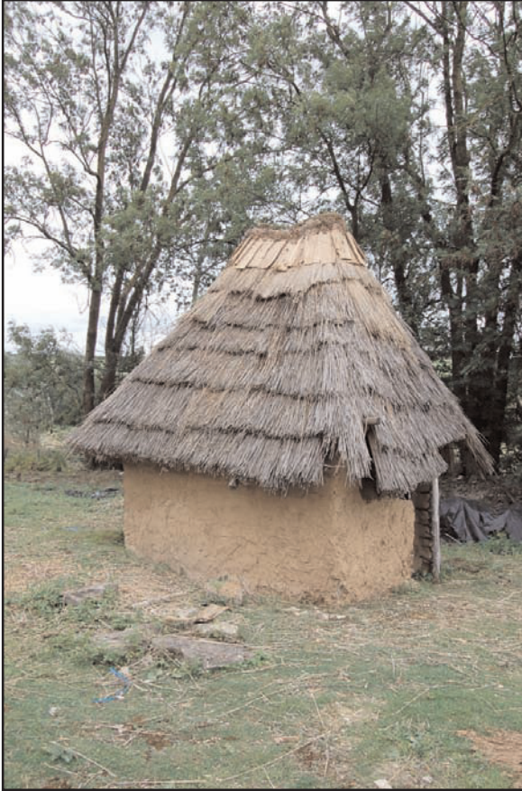
Fig. 28 : toiture et faitage achevés
