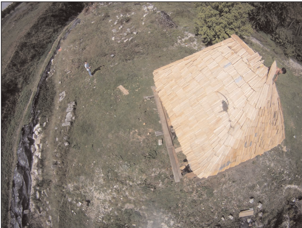
Fig.3 bis pose du dernier bardeau de l'arêtier
