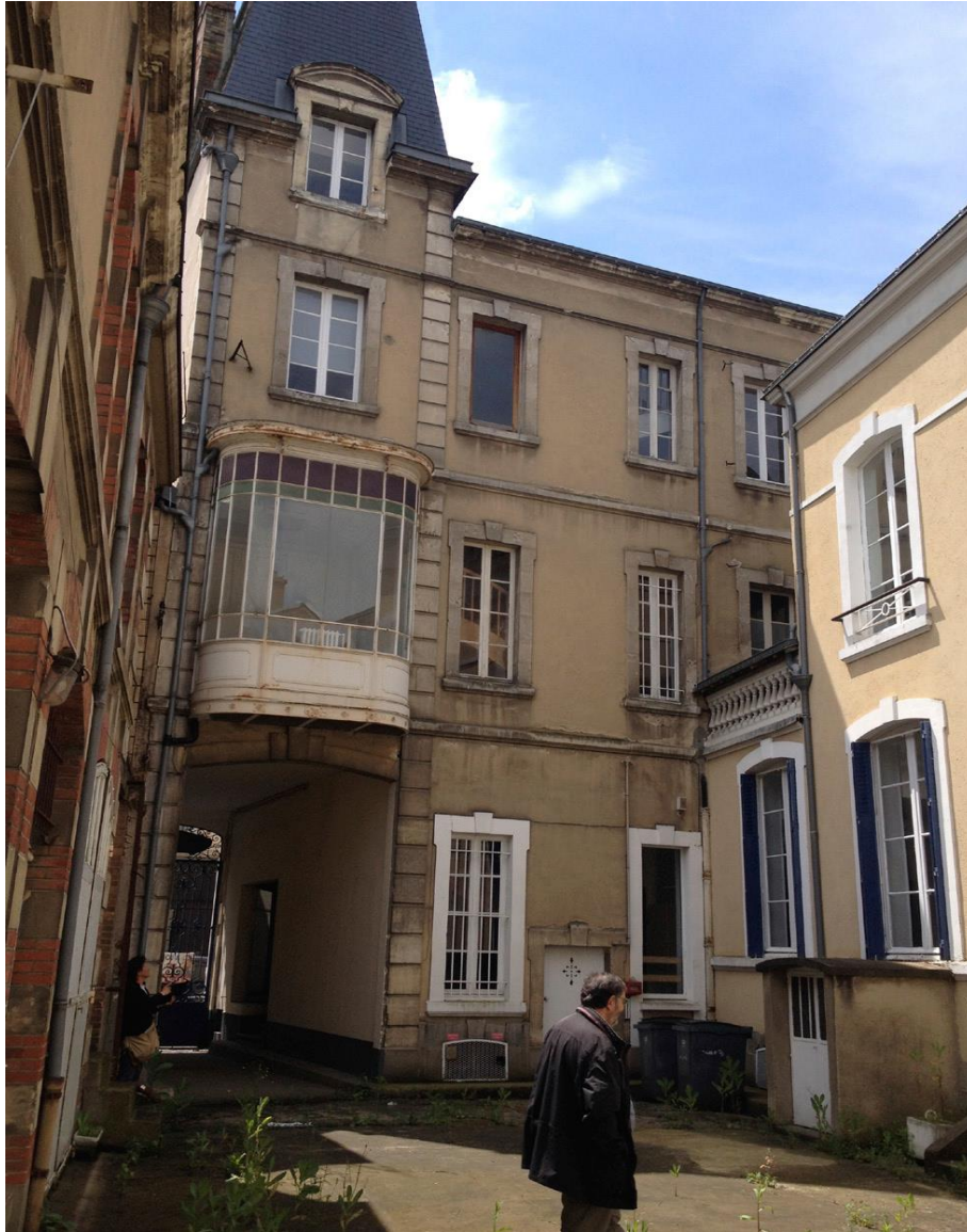
Cour intérieure bâtiment rue du Docteur Leroy, 2016, Le Mans. ©S. Eddoha
