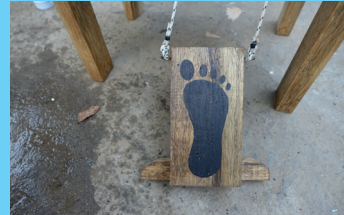
Un robinet « quart de tour » retenu par un tendeur à actionner par une pédale en bois. A "quarter turn" tap held back with a strong luggage-rack elastic and to be activated with a wooden foot pedal.
