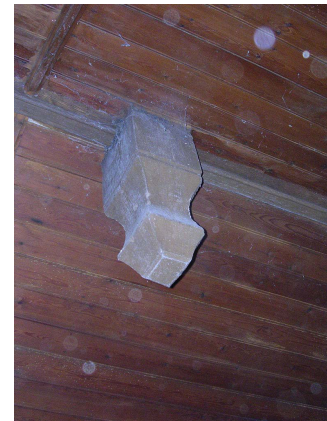
Cul de lampe des poinçons hauts
