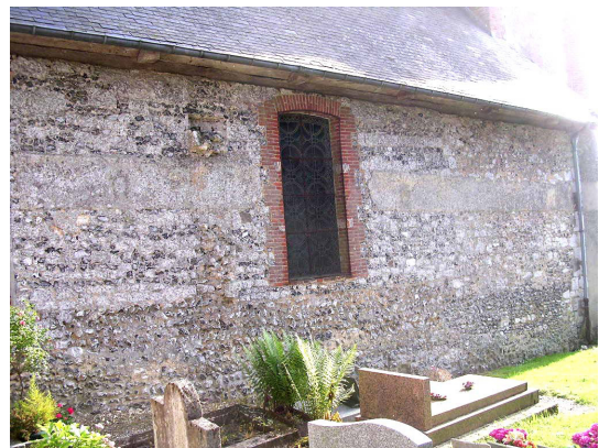
Mur nord de la nef, partie Ouest
