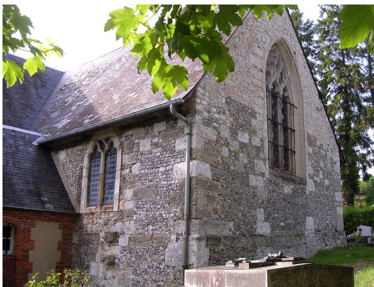
Vue sud-est du chœur, avec ses ouvertures néogothiques du XIXe siècle et les arrachements du contrefort sur le mur sud
