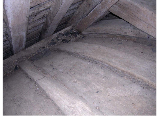
Cerces et planches courbes du voûtement
