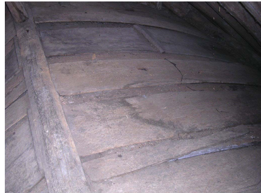
Cerces courbes et planches du voûtement d'origine
