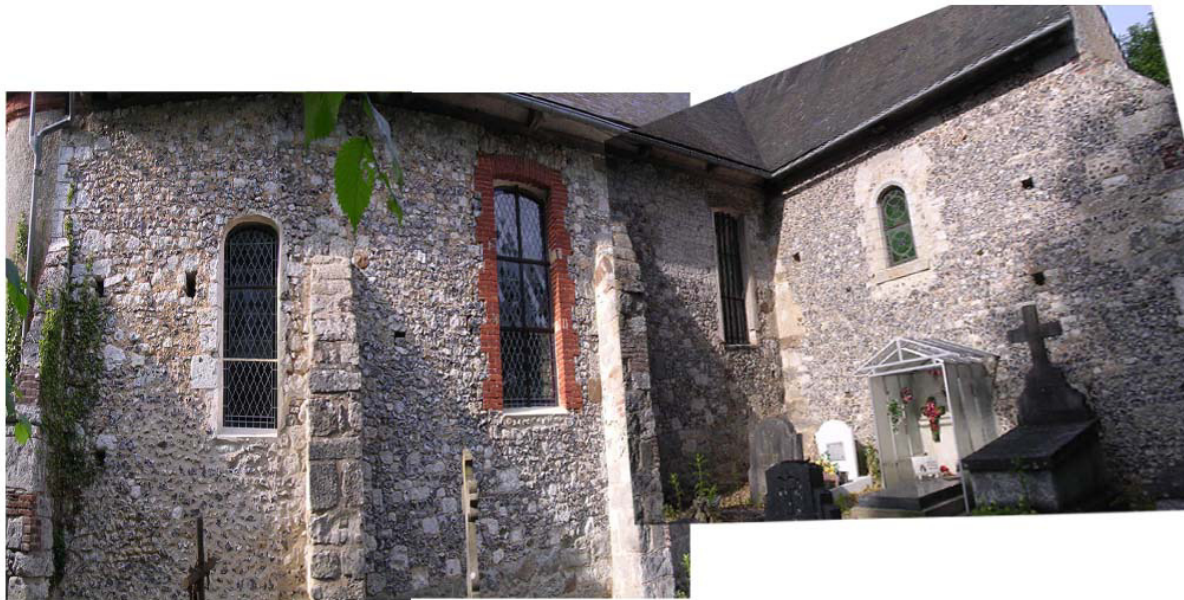
Elévations sud de la nef et du croisillon sud du transept
