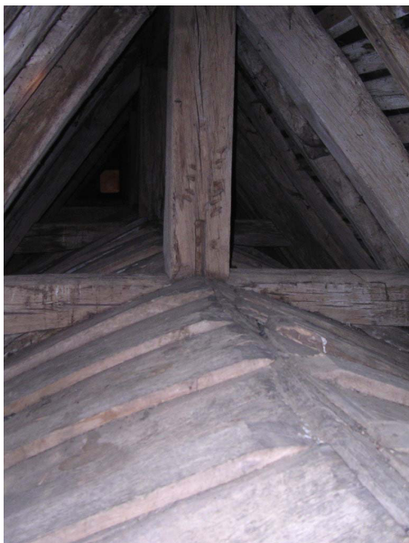
Mortaise de l'ancienne sous-faîtière, supprimée au XVIII e siècle (?).
