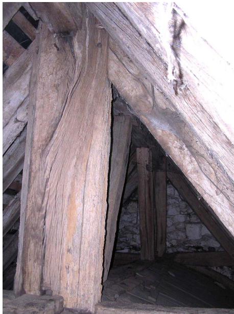
Partie haute du poinçon, de section octogonale
