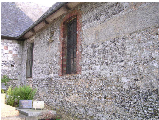
Mur nord de la nef, partie Est
