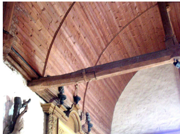
Grefe enturée à l'extrémité de l'entrait de la ferme du croisillon sud
