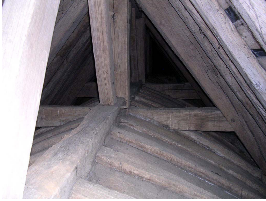
Structure des fermes de la nef
