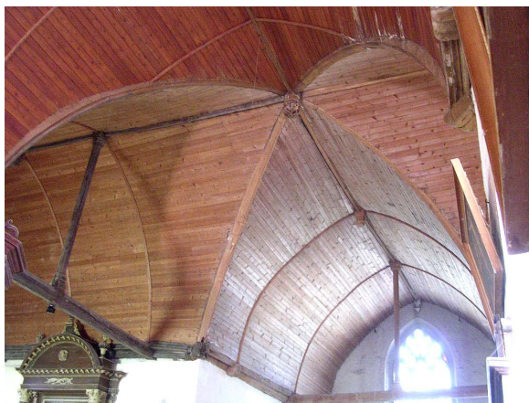
Charpente de la croisée et du chœur
