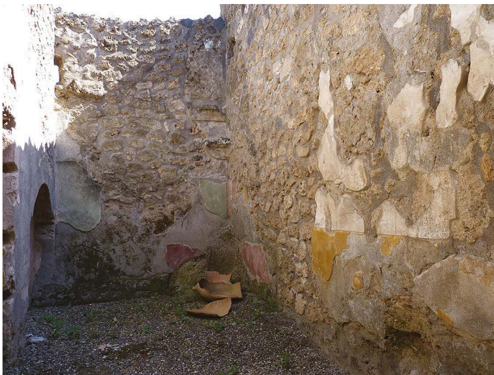
Fig. 3. La pièce (11) vue du nord.
