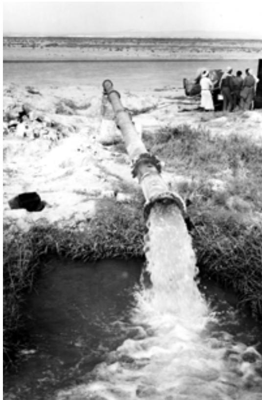
*Photo 3 : Pompage dans l'Euphrate pour l'irrigation, actionné par un moteur diesel.
