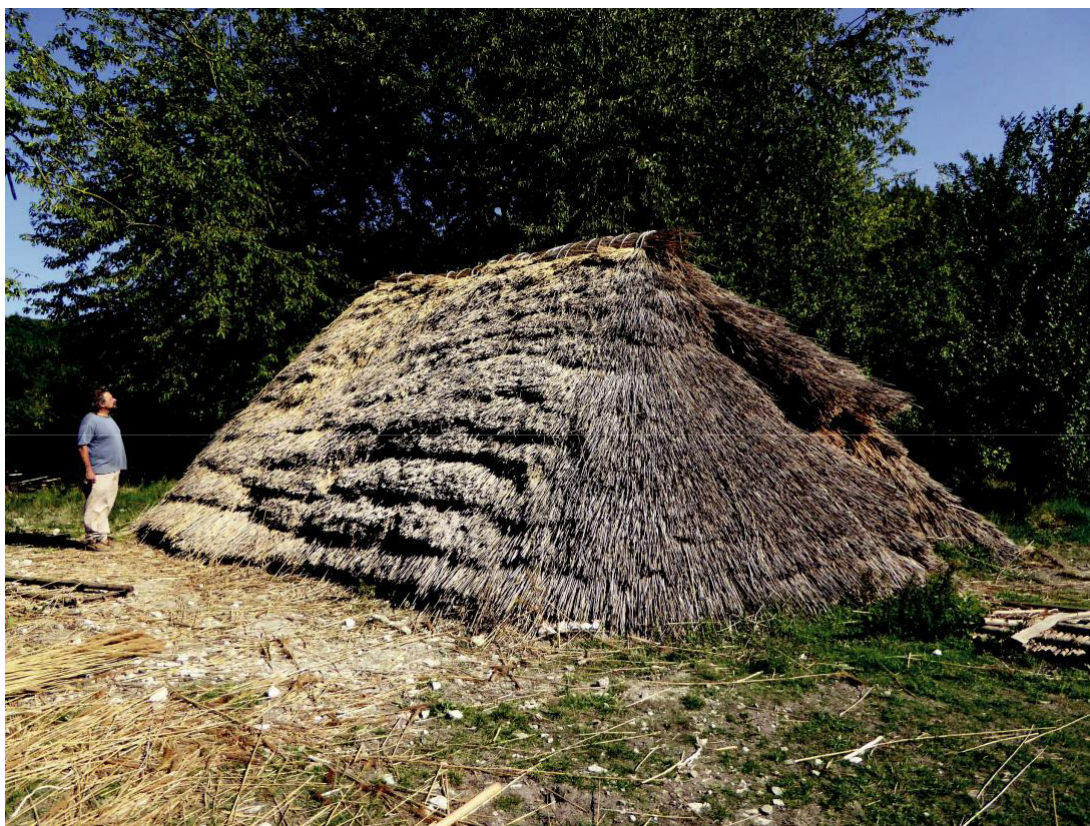
Figure 4.7 – Cellier achevé avec sa couverture en roseaux (Cl. F.E.)
