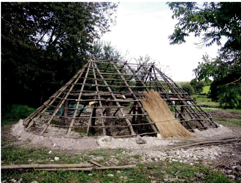
Figure 4.6 – Vue arrière du cellier avec son abside et le talus périphérique en pied de toiture (Cl. F.E.)
