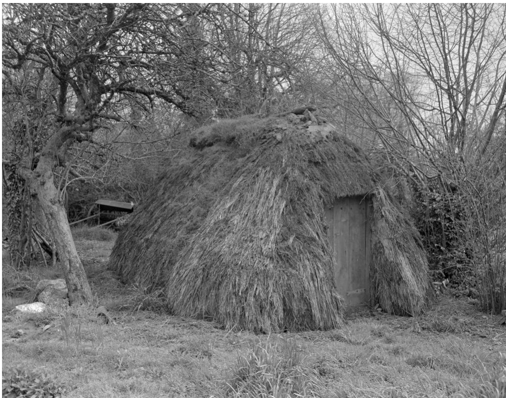
Figure 4.2 – Le Cambout (22), lieu-dit Le Gastry, tudio construit dans les années 1960 (Cl. Inventaire Bretagne, Ducouret et Tanguy-Schröer 1994)
