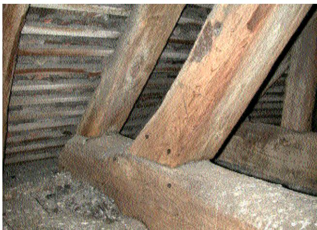
Fig. 16 Pieds de chevron et d'arbalétrier dans l'entrait. On distingue la marque V sur l'arbalétrier et le chevron.
