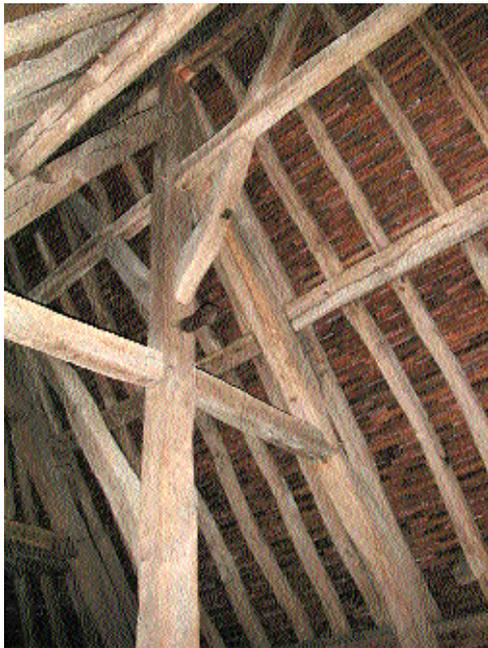
Fig. 3 Ferme de la charpente du choeur.
