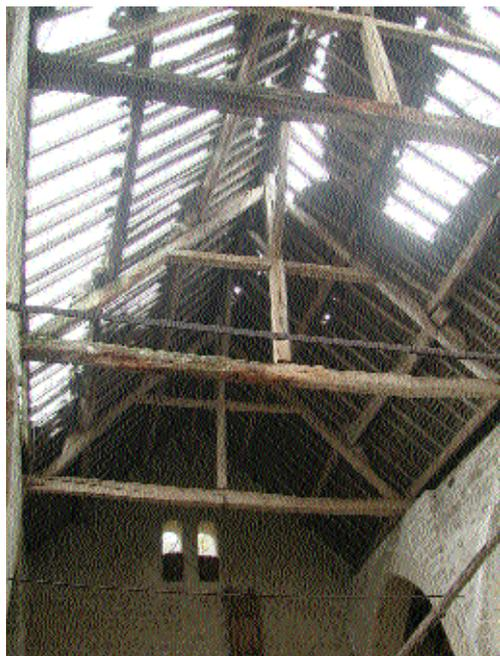
Fig. 4 Fermes à poinçon de fond sur la partie nord de la grange
