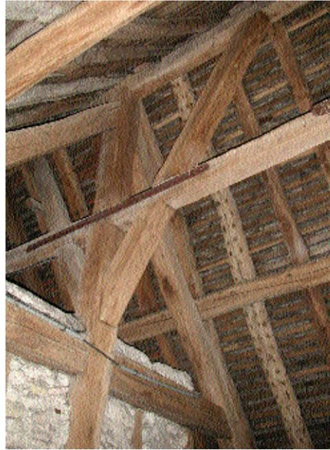
Fig. 6 Charpente du croisillon sud, étrésillonnement longitudinal
