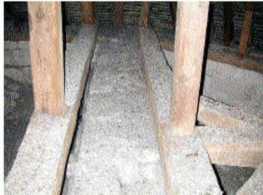
Fig. 12 Double cours de sablières avec leurs assemblages à tenon-mortaise.
