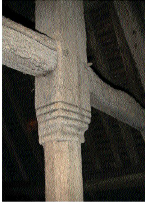
Fig. 7 Moulures du poinçon de la ferme principale.
