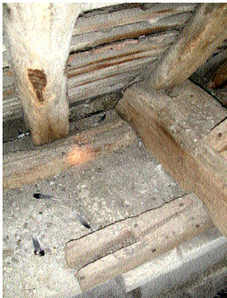
Fig. 13 Encoche latérale taillée dans le flanc de l'entrait destinée au mi-bois de la sablière.
