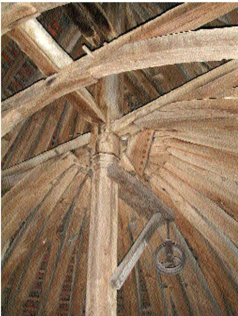
Fig. 15 Enrayure des entrails assemblés dans la ferme de croupe. Pied de poinçon sculpté.
