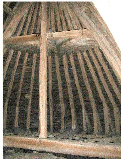
Fig. 4 Croupe à chevrons-formant-fermes de la charpente du choeur.
