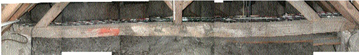
Fig. 12 Réemploi en entrait d'un entrait roman. On distingue les entailles des assemblages à mi-bois à queue d'aronde pour les éléments de raidissement de la ferme primitive.
