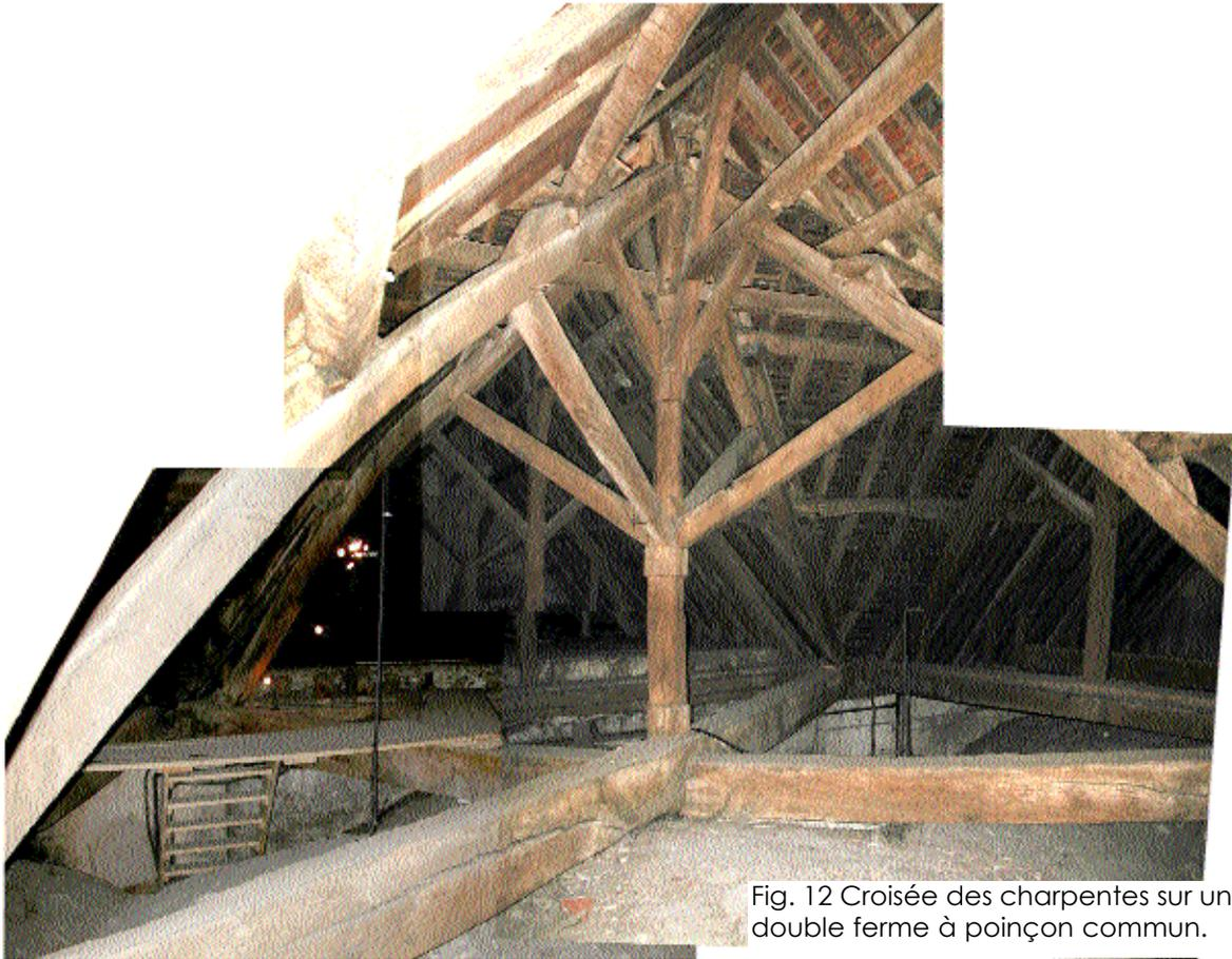
Fig. 12 Croisée des charpentes sur une double ferme à poinçon commun.
