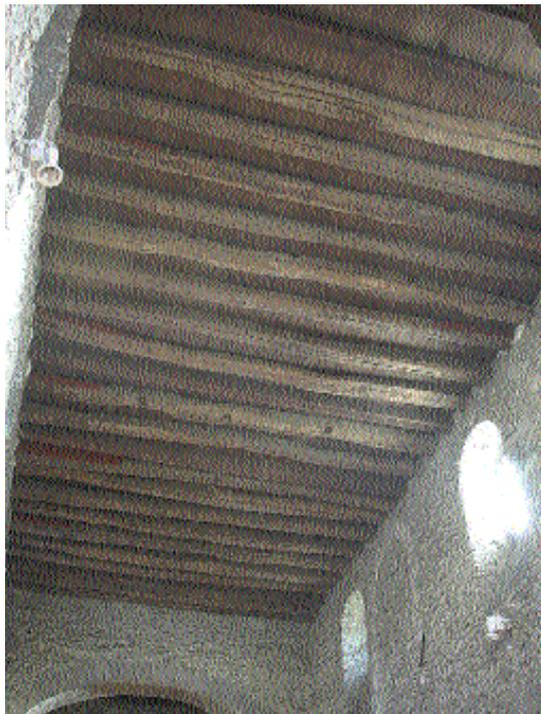
Fig. 3 Plafond de la nef du XIXe siècle. Les entrails romans en réemploi se distinguent par leurs entailles d'assemblages à mi-bois et les rainures taillées sur leurs flancs. On remarque une baie romane primitive murée entre les deux fenêtres.
