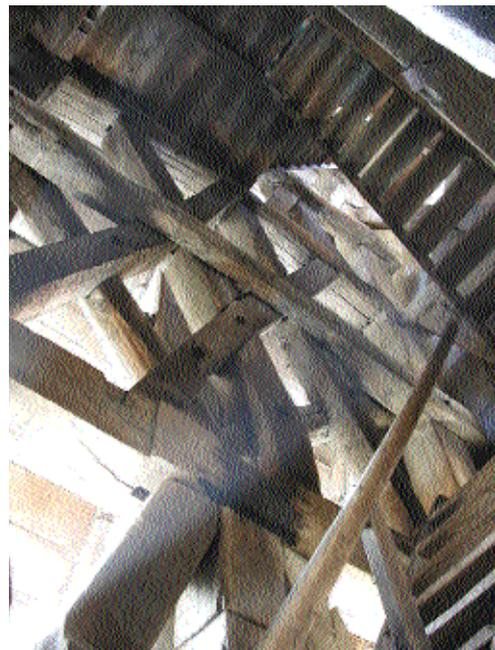
Fig. 10 Pan de bois nord, longitudinal à la deuxième chambre, avec ses écharpes entrecroisées, maintenues en partie haute par des moises boulonnées.
