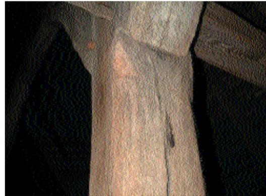
Fig. 22 Chanfrein aux arêtes du poinçon.
