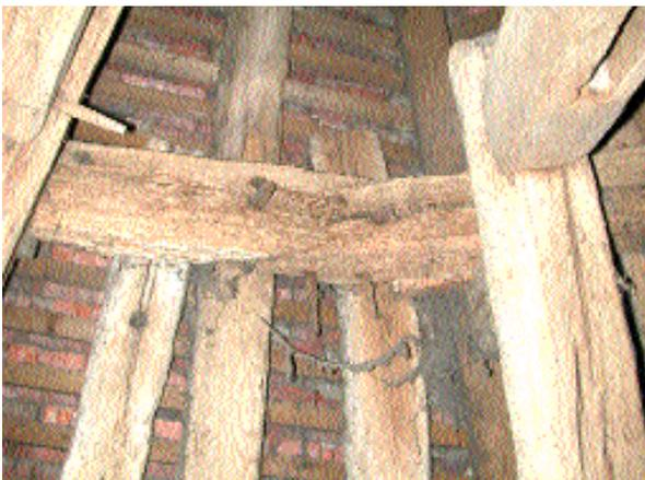
Fig. 8 Assemblage à mi-bois des pannes de la croupe.
