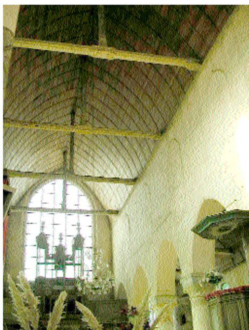
Fig. 3 Charpente voûtée et lambrissée de la nef.
