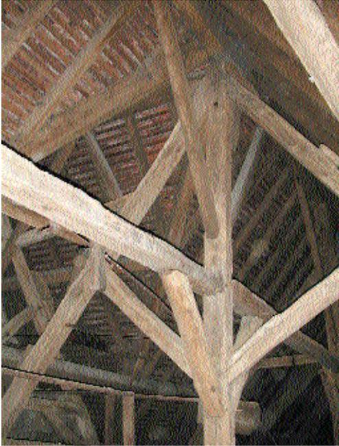
Fig. 5 Sous-faîtage de la charpente du choeur.
