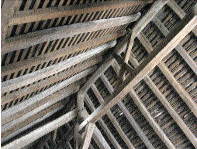
Fig. 4 Etrésillonnement longitudinal des fermes du chœur.
