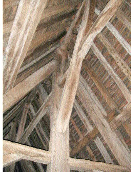
Fig. 11 Enture des pannes assemblées au droit d'un arbalétrier, sur une échantignole.
