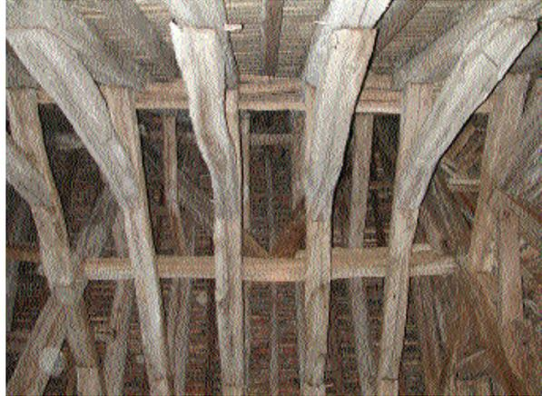
Fig. 2 Etrébillonnement longitudinal des fermes principales : faîtière, sous-faîtière et liens obliques de contreventement, indépendants des fermes secondaires.
