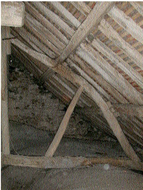
Fig. 18 Charpente du bas-côté nord de la nef.
