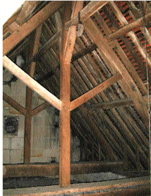
Fig. 8 Pied de chevrons avec jambe de force et blochet.
