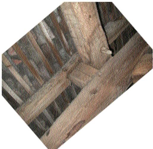
Fig. 15 Assemblage par une enture biale des pannes, calées sur une échantignole tenonnée à l'arbalétrier et au chevron.
