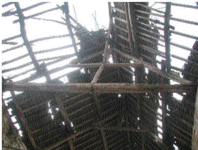
Fig. 5 Fermes à poinçon de fond sur la travée médiane
