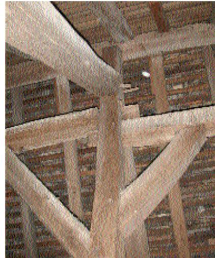
Fig. 5 Assemblages à tenons traversants des sous-faîtières dans le pignon.
