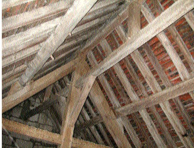
Fig. 7 Etrésillonnement longitudinal des fermes du transept.
