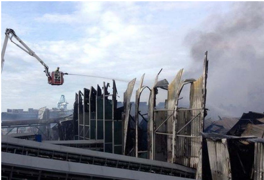
Une partie du centre Multifilières de traitement des déchets ravagé par les flammes 86
