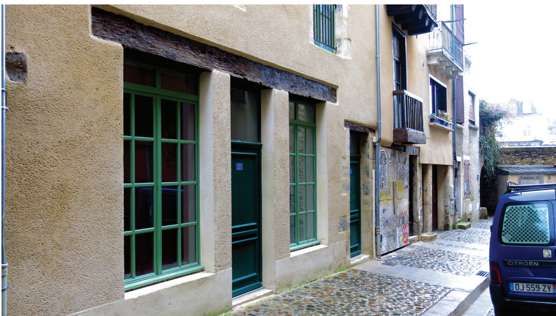
Fig. 9 : Des logements rénovés issus d'une opération de l'OPAH-RU.
