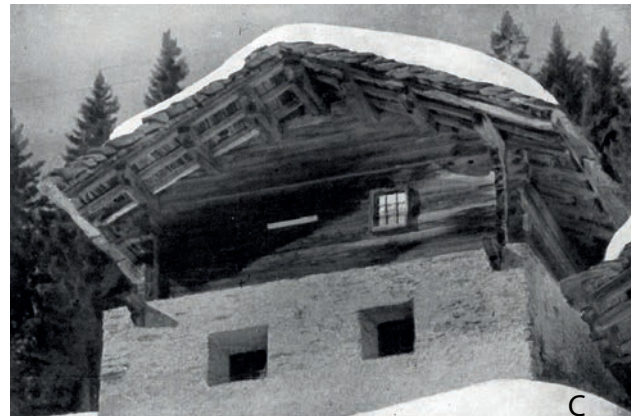
Figure 2 : Possibles scènes de construction de bâtiments (A : d'après Anati 1960, p. 144, fig. 55 ; B : d'après Anati 1960, p. 220, fig. 101) et photographie d'un chalet alpin (C) avec des pannes débordantes (Haute-Savoie, France ; d'après Cereghini 1957, p. 357).
