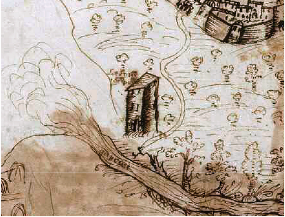
Fig. 6 - La tour du Gapeau, fin du XVI e siècle, détail
