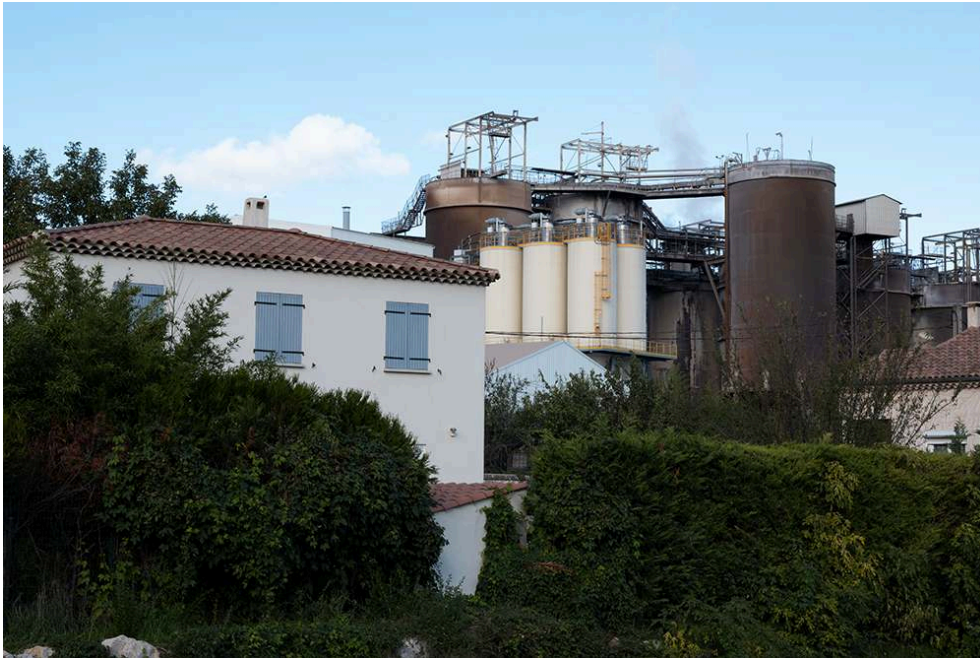
7- Vue de l'usine, proche des habitations, prise depuis l'Avenue Victor Hugo, Gardanne, 20/9/2019 © B. Juanals
