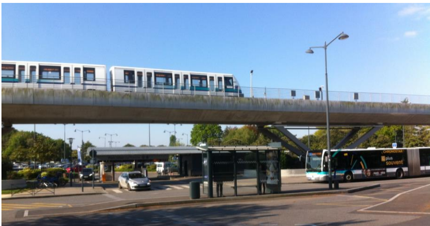
Photo 5 (Cyprien Richer, avril 2017). Pôle d'échanges de la station de métro La Poterie à Rennes. Le terminus de ligne de métro est en contact avec un pôle bus et un parc-relais, dont la capacité va prochainement être étendue à 700 places (ouverture prévu en 2021). La halte ferroviaire du même nom ne constitue pas un enjeu de connexion important et demeure trop excentrée de la station de métro pour permettre des correspondances efficaces.
