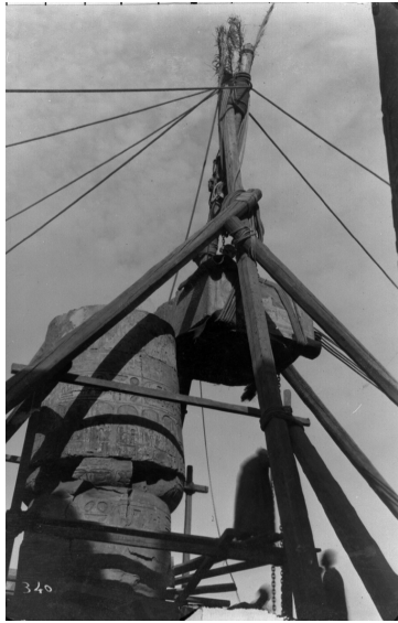
Fig. 8. Démontage de l'abaque d'une colonne de la salle hypostyle. © CNRS-CFEETK (26919).
