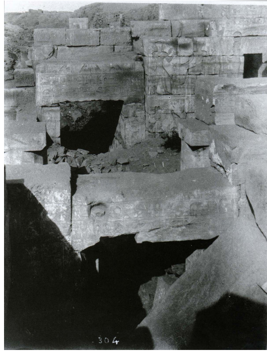
Fig. 8. Démontage de l'abaque d'une colonne de la salle hypostyle. © CNRS-CFEETK (26919).
