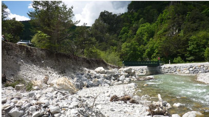
**Fig. 3 : Érosion de berge et accumulation d'alluvions au pont de Baumugnes**
