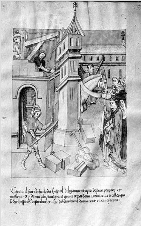
Construction de l'hôpital de Dijon
