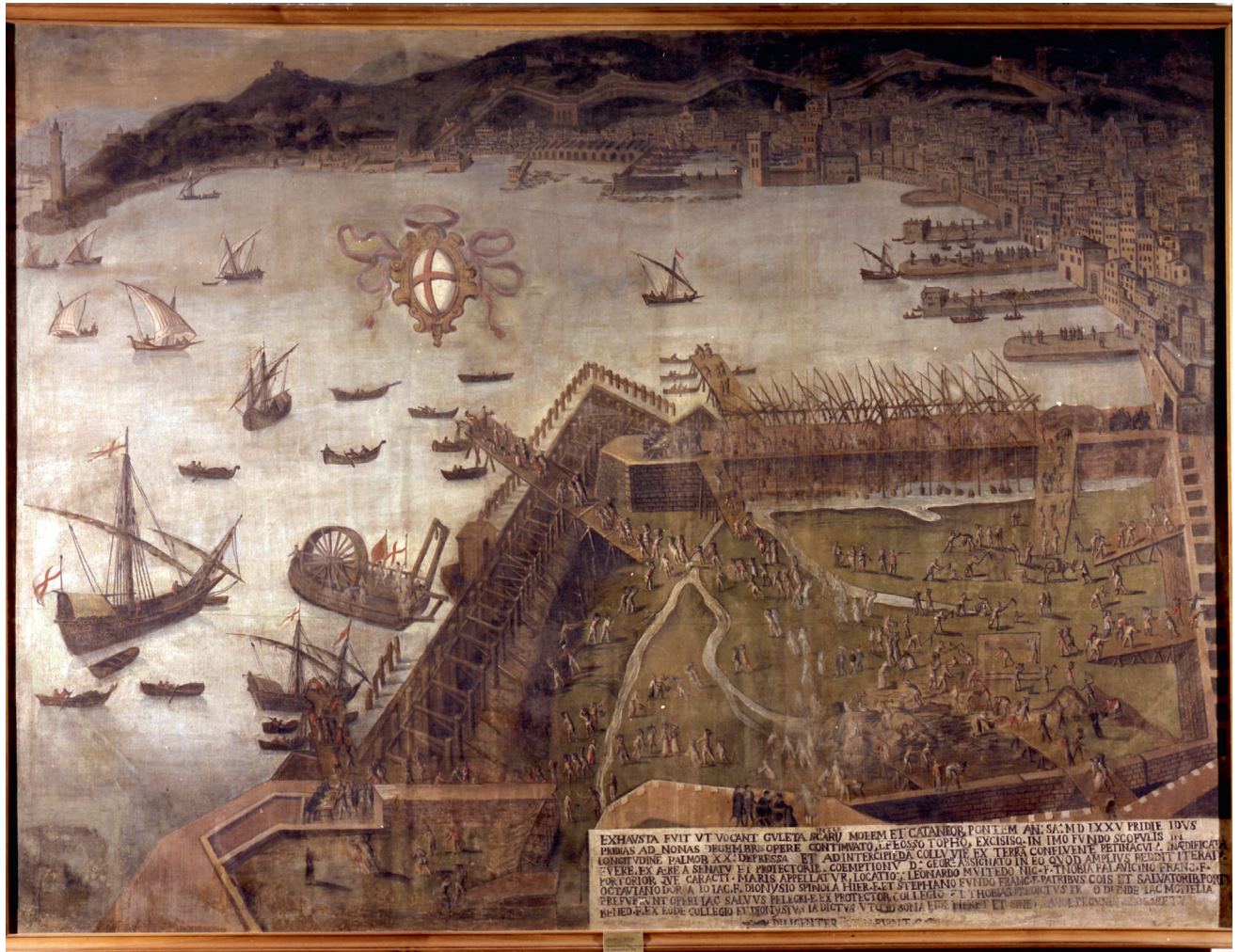
Fig. 2: Dionisio di Martino, Escavazione del fondo marino del Mandraccio nel 1575, second half of the 16 th century (N.I.M.N. 3513, courtesy of Galata Museo del Mare-MuMA, Genoa).
