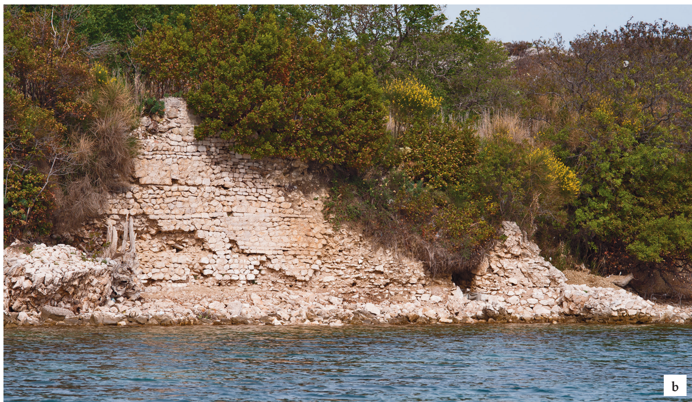
Fig. 3 – a : Caska, crique de Mala pošta. Vue depuis l'Est du mur de terrasse écroulé et arasé. À gauche de l'image, les bouées rouges indiquent la position des zones A-B-B2. En arrière-plan la tour de guet des thons Turan/Tunera. b : Vue depuis le Sud du mur de terrasse ici conservé sur plus de 5 m de hauteur (clichés Ph. Groscaux, AMU, CNRS, CCJ).
