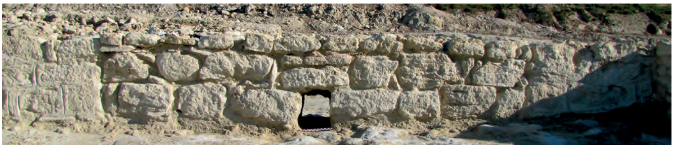
Fig. 142. Bâtiment 1, pièce 2. Parement ouest du mur 2002 avec ouverture murée et chantepleure (cliché Fr. Marty).
