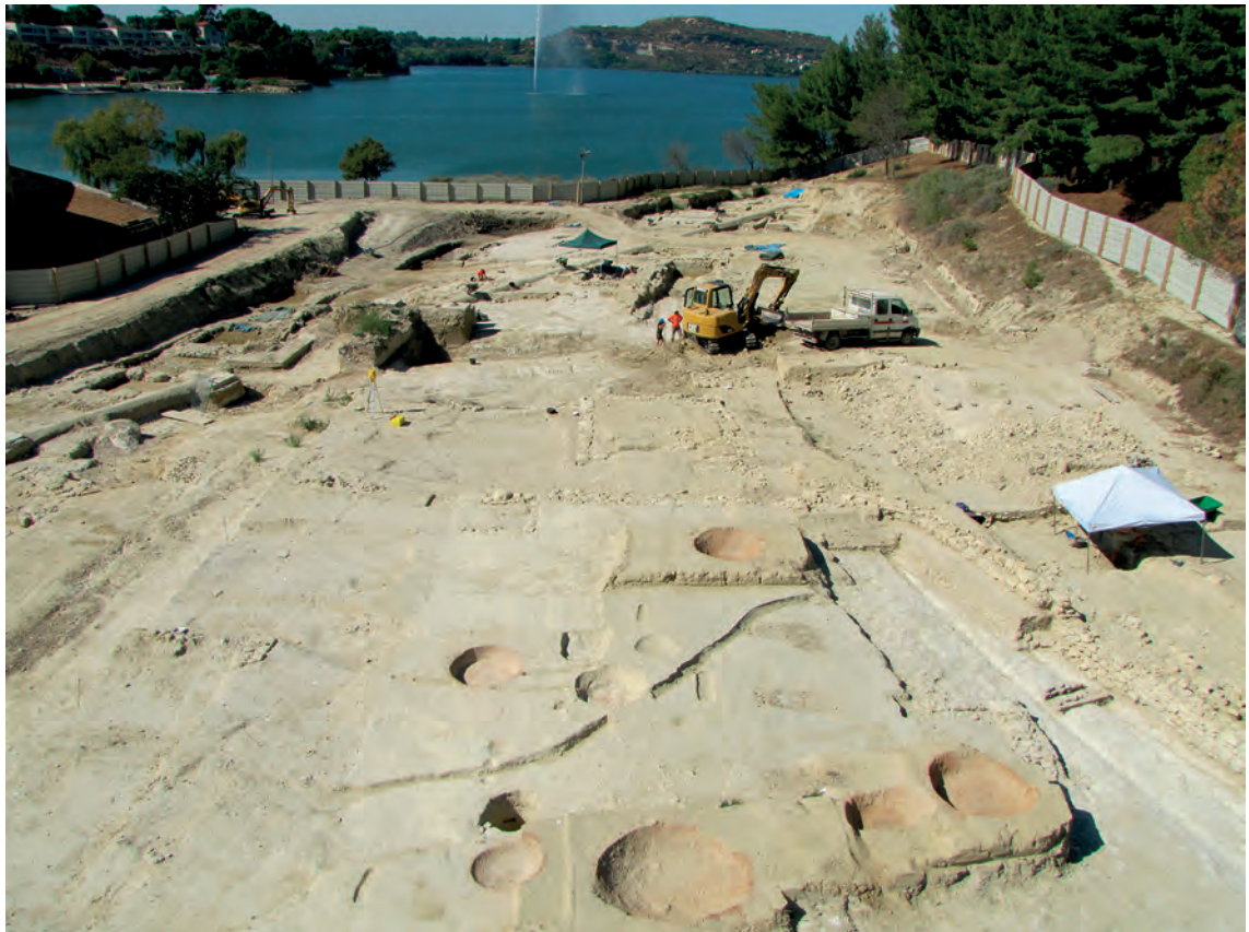
Fig. 7. Vue générale du chantier depuis le sud (cliché Fr. Marty).
