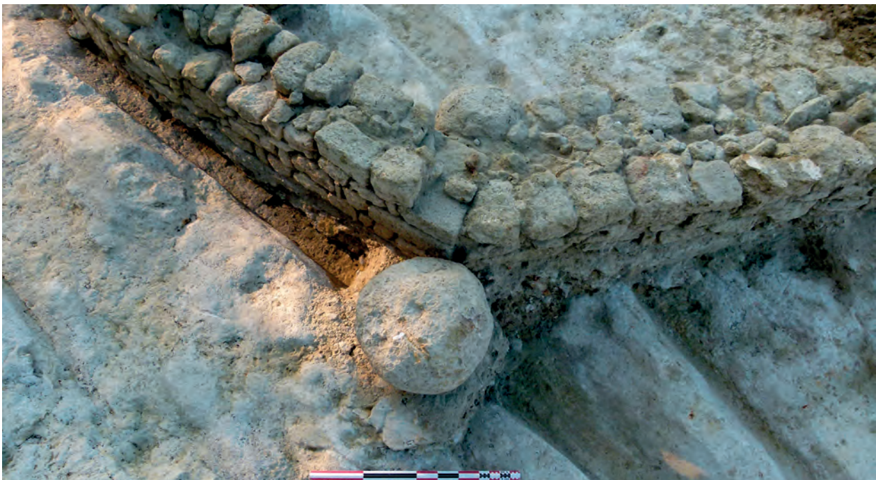
Fig. 59. Chasse-roue protégeant l'angle des murs 2020 et 2181, le long de la voie 2192 (cliché Fr. Marty).
