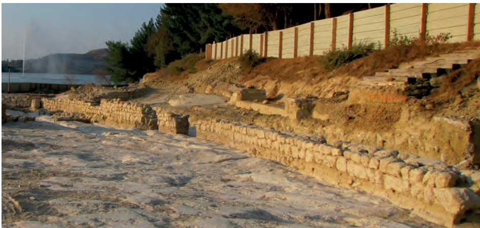
Fig. 229. Jardin 15. Mur de clôture 2020 vu du sud-ouest (cliché Fr. Marty).
