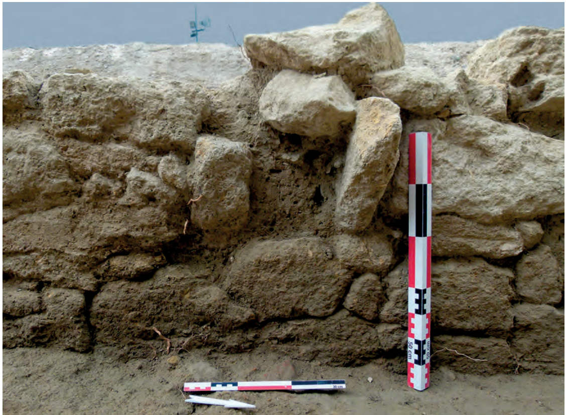
Fig. 141. Bâtiment 6, hangar 31. Chantepleure dans le parement est du mur 20 (cliché Br. Chevaux).
