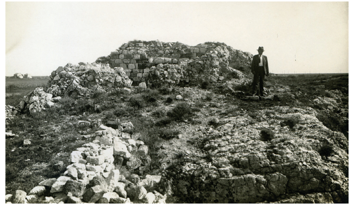
Fig. 7 : La tour du Castellás vue du nord-ouest en 1933. Fernand Benoit se tient à l'emplacement d'un grand bloc de pierre taillé (cliché C. Naudot; Ville d'Avignon – Palais du Roure – Fondation Flandreysy-Espérandieu).
