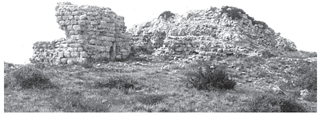
Fig. 8 : Tour d'angle sud de l'enceinte du Castellas, vue du sud-ouest en 1933 (cliché C. Naudot ; Ville d'Avignon – Palais du Roure – Fondation Flandreysy-Espérandieu).
