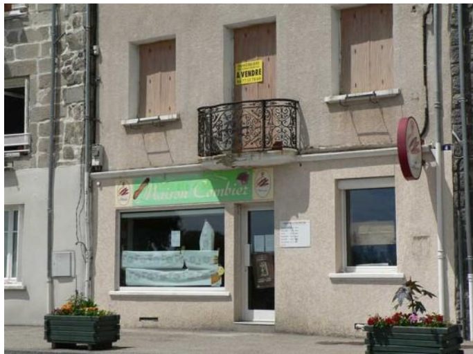
Une image banalisée : la fermeture des commerces et des services de proximité dans les centre-bourgs (Egletons, Corrèze, 2016).
