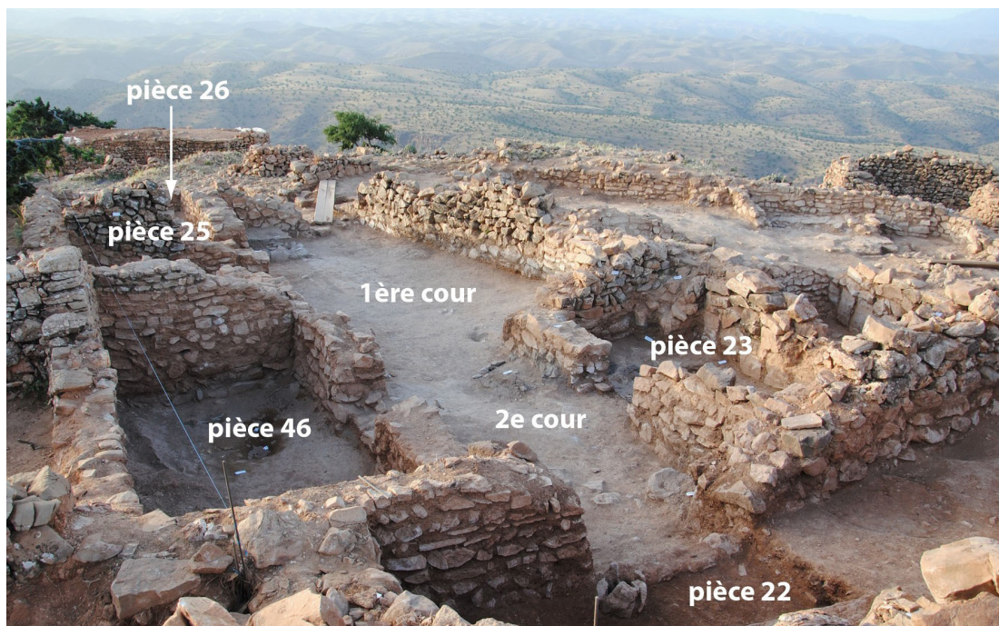
Fig. 5 : Vue générale de l'ensemble résidentiel de la Mḥadra (levé/DAO : R. Schwertdner – Mission archéologique Igiliz 2011)
