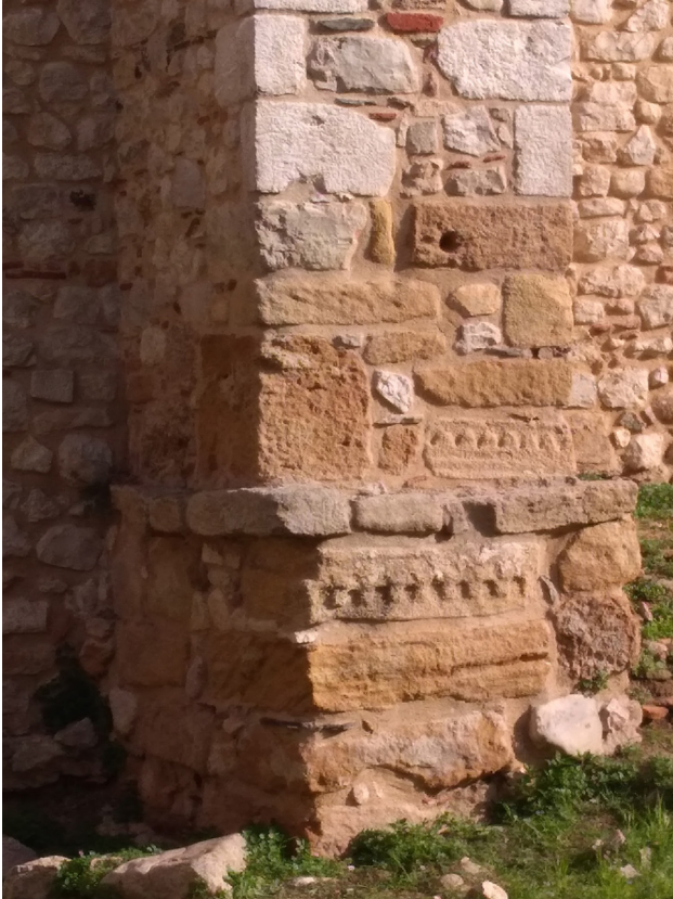
Figure 3: Contrefort nord de l'église de Sant Martí d'Empúries avec blocs en réemploi (cliché: Rodolphe Martinez).
