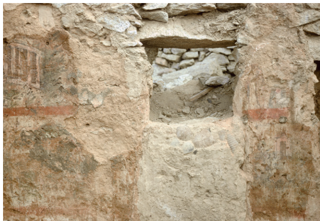
FIG. 16b. Mur est, portique et porte bouchée.
