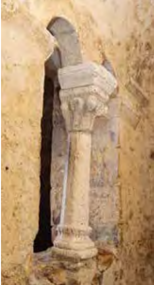
fig. 16 - Fenêtre prenant la lumière en second jour depuis le bain. Comme ailleurs dans la ville, les arcs de chaque baie sont formés de trois claveaux. Le claveau s'appuyant sur la colonnette est commun aux deux baies. Sa forme et son décor sont semblables à ceux des fenêtres en usage dans l'architecture domestique montpelliéraine de la fin du XII e siècle.
