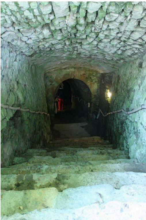
Fig. 12 : Château de Talmont. Accès voûté au souterrain de stockage (XIII e -XIV e siècle)
