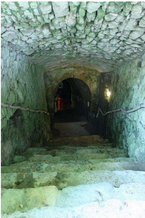
Fig. 12 : Château de Talmont. Accès voûté au souterrain de stockage (XIII e -XIV e siècle)
