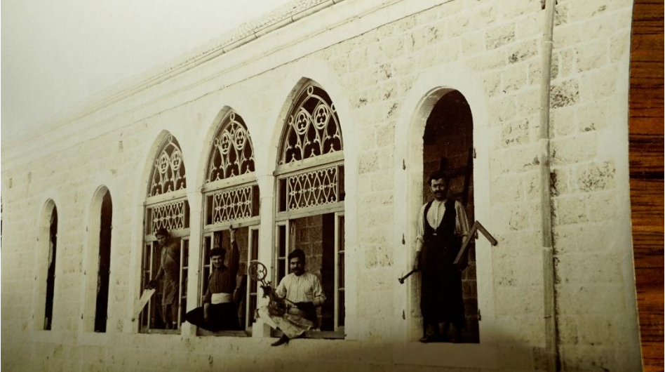
Illustration 11 : Séminaire syrien de Charfé en chantier (Arch. Ganagobie)
