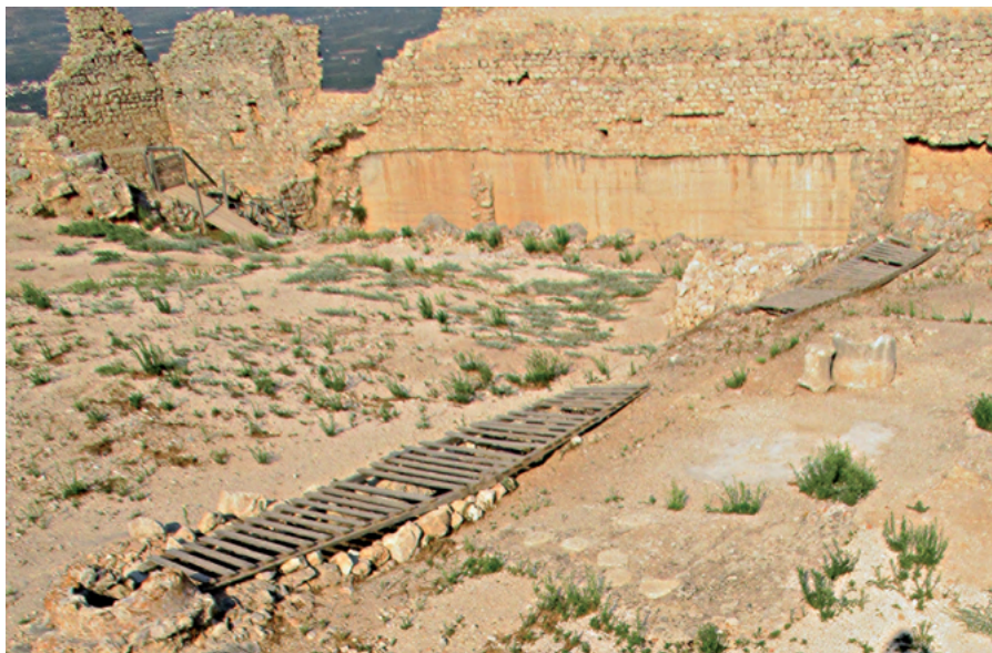
Fig. 8 – La citerne de la Larisa, depuis le sud-ouest (© R.Bardet).
