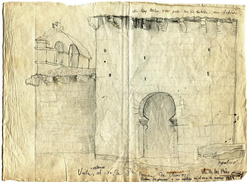
Fig. 3. Vista exterior al N de S n Román de Moroso, 1858. Archivo Ángel de los Ríos, Torre de Proaño.
