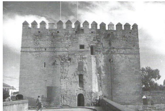
Fig. 13 y 14. La torre de la Calahorra después de su restauración (Solano 2007).
