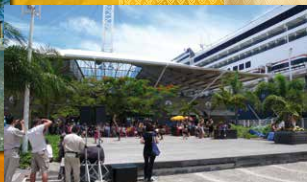
La troisième gare maritime, conçue par l'architecte François Raulet, coll. Yves Jacquier
