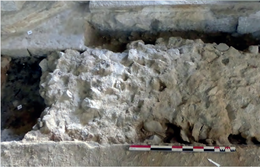
Fig. 3 Probable radier de fondation d'un sol d'époque romaine dont la surface a été desquamée. Cliché T. Dessolin, en direction du nord-est.
