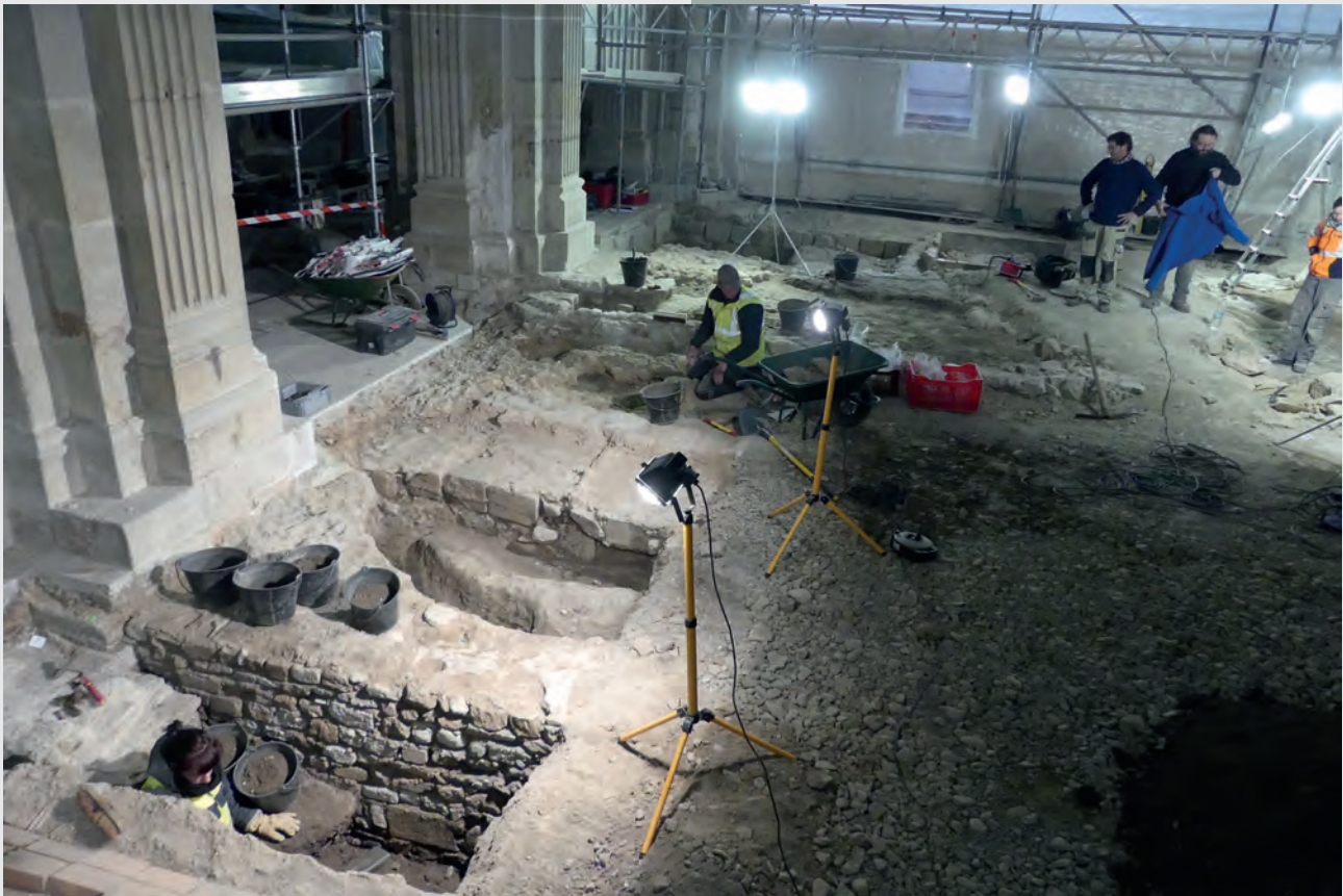
Fig. 6 Vue oblique de l'intervention du SAVA, au premier plan, concomitante à celle du CEM au second plan. Au premier plan, on observe la puissante infrastructure maçonnée séparant les 5 e et 6 e travées, vraisemblablement les fondations du jubé du cardinal Rolin. Cliché Y. Labaune.
