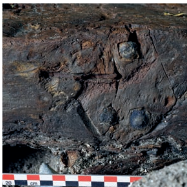
Fig. 6-65 Détail de la rustine sur la joue sud de la quille (Cl. Ph. Groscaux).
