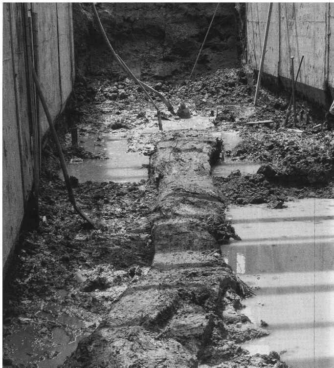
Fig. 8 : Fossa Augusta . Vestige de quai via S. Alberto (Maioli 2001, 222, fig. 3).
