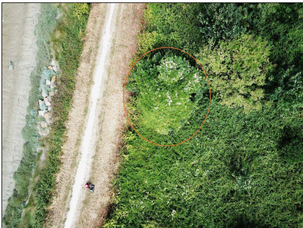
Photo 7 - Enfrichement des digues et taches d'invasives ( Reynoutria japonica ). [cliché : auteurs, 2020]
