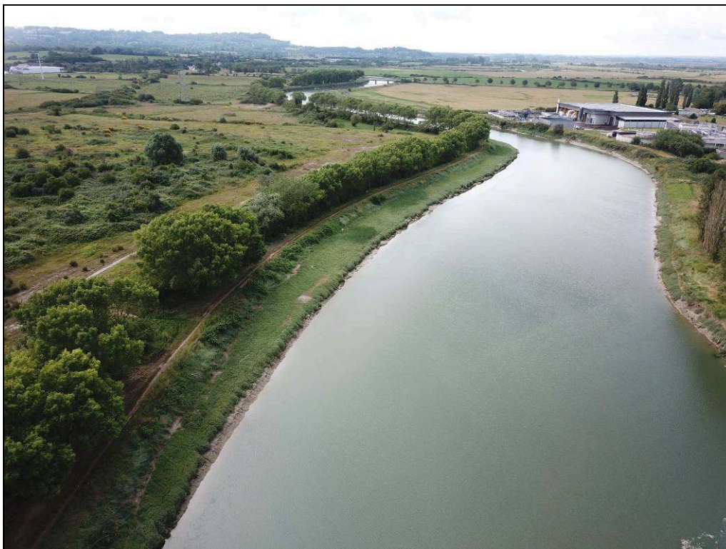
Photo 3 - Deux rives bordées de digues de terre végétalisées. [cliché : auteurs, 2020]
