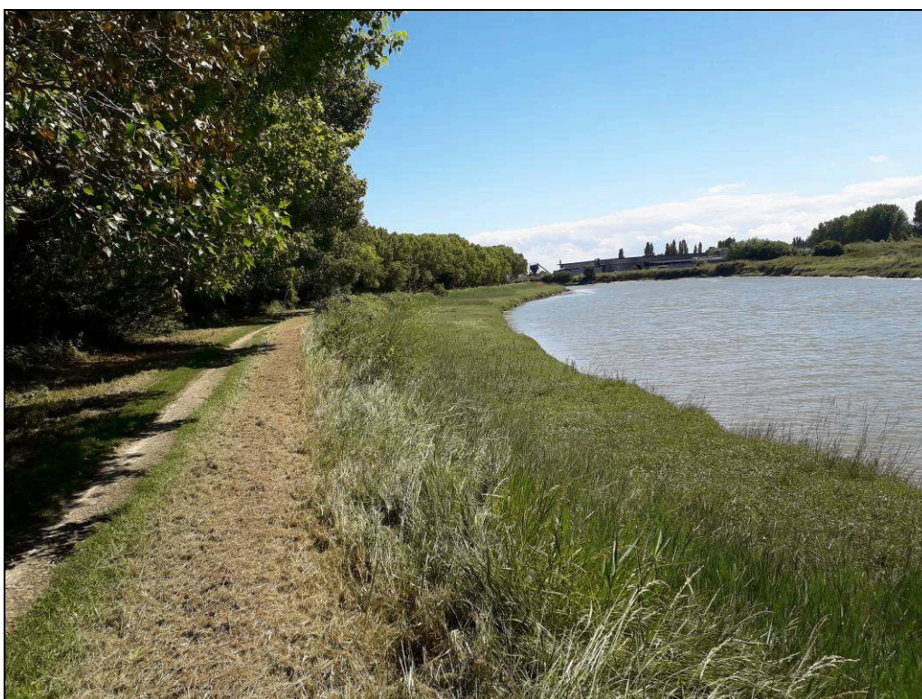
Photo 4 - Une digue de terre en bordure de la Dives. [cliché : auteurs, 2020]
