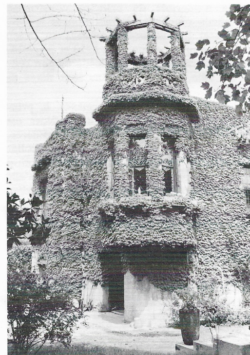
4. Villa Lafont, état actuel, Tourelle d'angle.
